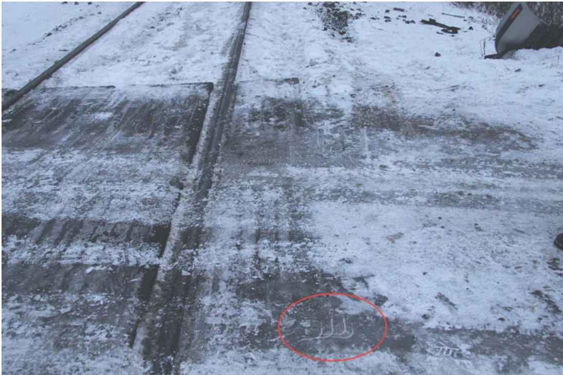
Kuva 8. Kuvan alareunassa näkyy auton oikean etupyörän tasoristeyksen lankutukselle jättämä raapaisujälki.
