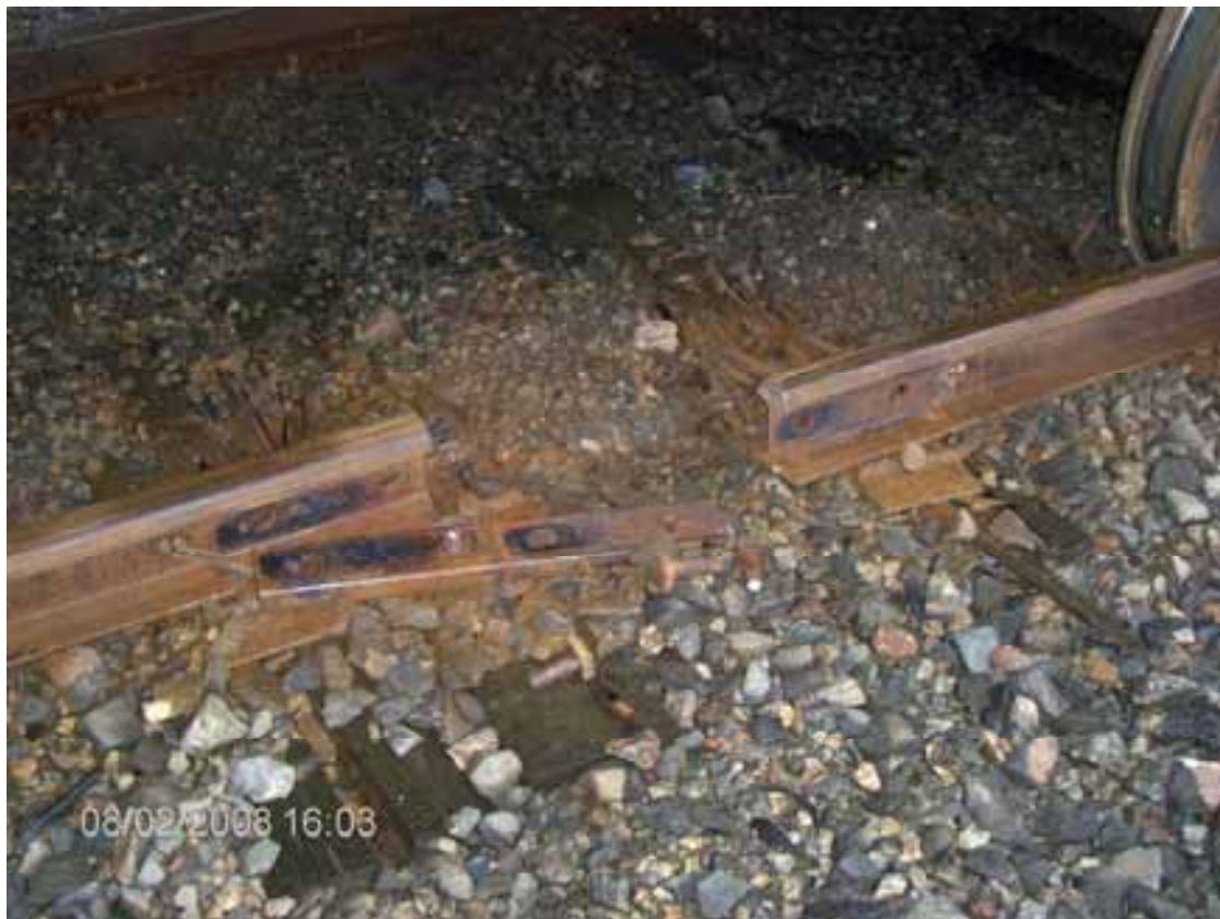
Kuva 6. Raiteen 107:n puiset ratapölkkyt olivat huonokuntoiset ja kiskot naulakiinnitteiset. Suistuminen oli aiheuttanut sidekiskon kiinnityspulttien katkeamisen.
