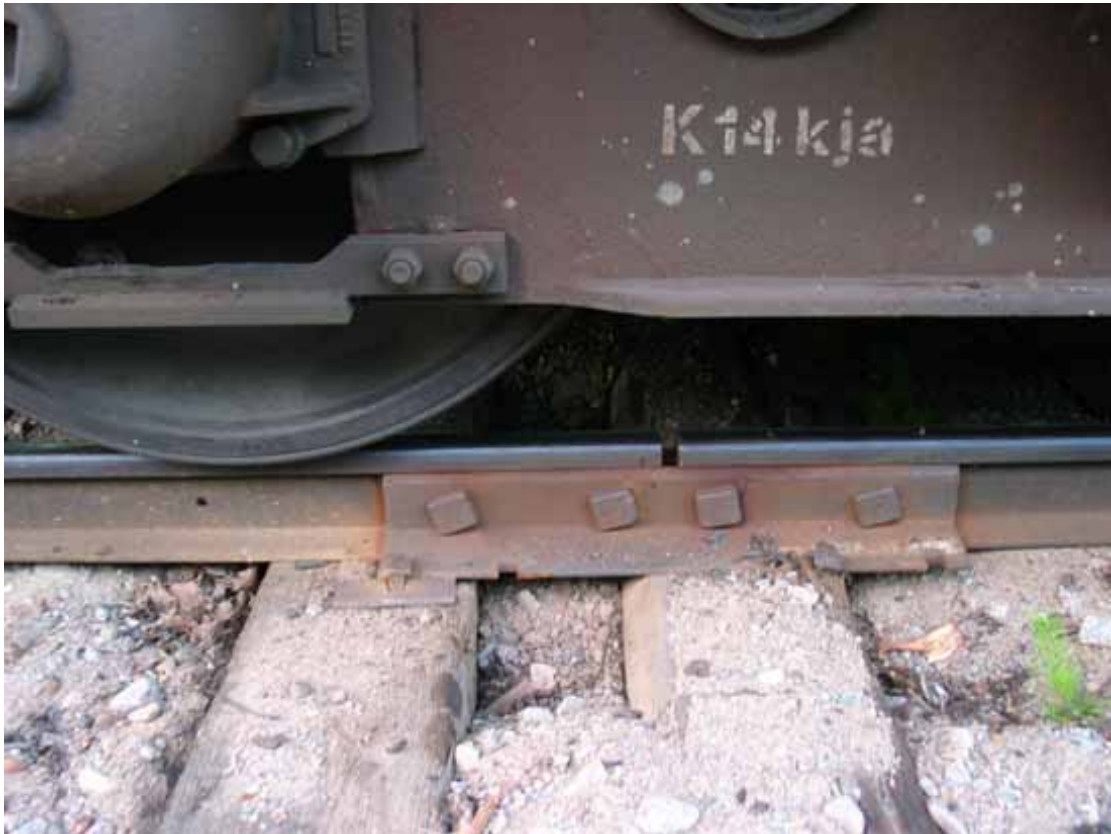
Kuva 7. Kiskon vaelluksen seurauksena kiskojatkos oli siirtynyt ratapölkyn päälle.
