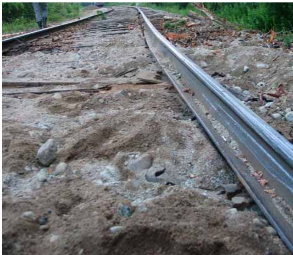
Kuva 9. Kaatunut ulkokisko suistumispaikalla. Kiskon uuman sisäpinnassa näkyi pyörrien tekemiä jälkiä.
