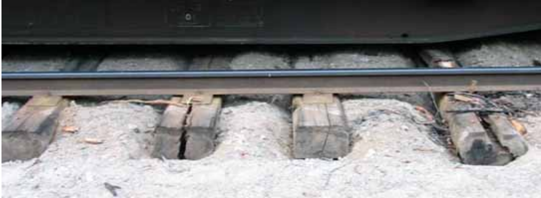
Kuva 5. Kuvassa näkyy ratapölkkyjen huono kunto.
