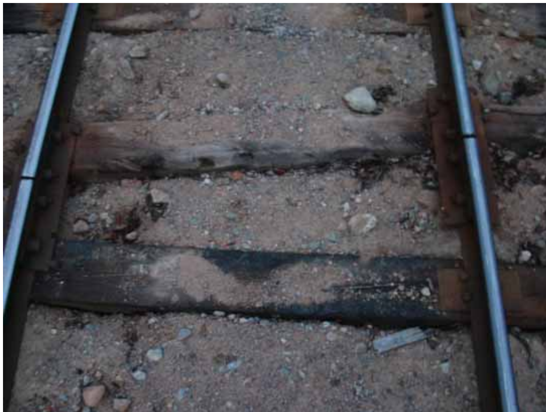
Kuva 8. Kiskojen vaelluksen seurauksena jatkosten paikat olivat eri kohdissa.
