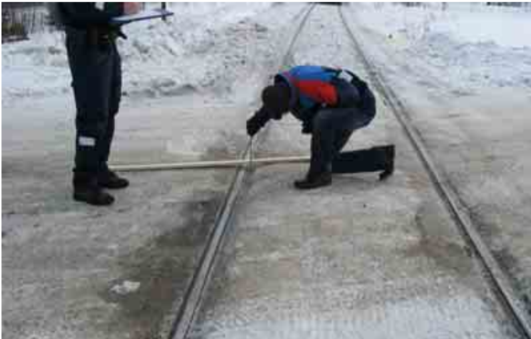
Kuva 21. Urasyvyyden mittausta kiskojen kohdalta. Mittauskohdan takapuolella näkyy auton vasemman eturenkaan jättämä jälki.
