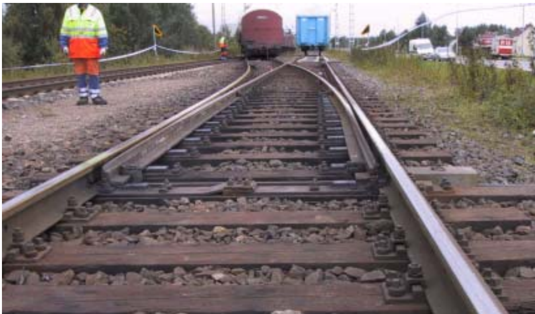
Kuva 6. Vaihteen kielet väliasennossa, jossa kumpikin kieli on jonkin verran auki.
