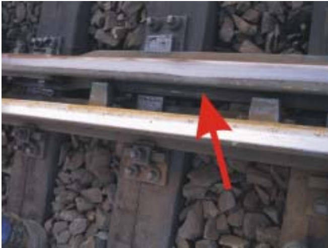
Kuva 7. Ensimmäinen jälki vasemmanpuoleisten pyörien putoamisesta kiskoilta näkyi 4,8 metrin päässä vaihteen kielen kärjestä. Nuolen osoittamassa kohdassa pyörän laipan tekemä jälki vaihteen kielen jalassa.
