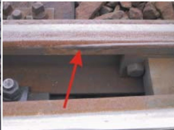
Kuva 8. Oikeanpuoleiset pyörät lähtivät putoamaan 5,4 metrin päässä (lähempi punainen nuoli) ja putosivat 7,0 metrin päässä kielen kärjestä (vasen kuva). Putoamiskohta myös oikean puoleisessa kuvassa.
