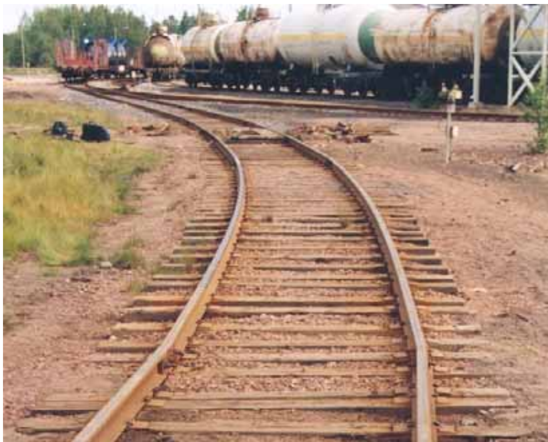
Kuva 3. Rataa onnettomuuspaikalla. Kuvasta näkyy tukikerroksen vajaus ratapölkkyjen päässä.
