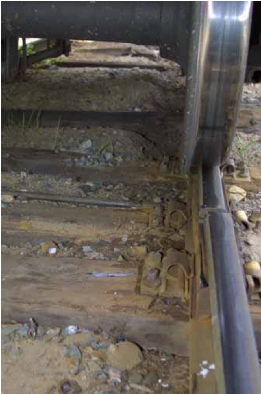
Kuva 3. Kiskojen jatkosten kohdalle oli muodostunut sivupiikki.
