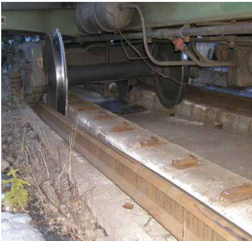
Kuva 3. Kuvassa näkyvät aluslevyihin hitsatut j-kiinnikkeet. Ulkokaarten puoleiset raudat ovat irronneet aluslevyistä ja kisko on siirtynyt pois paikaltaan.
