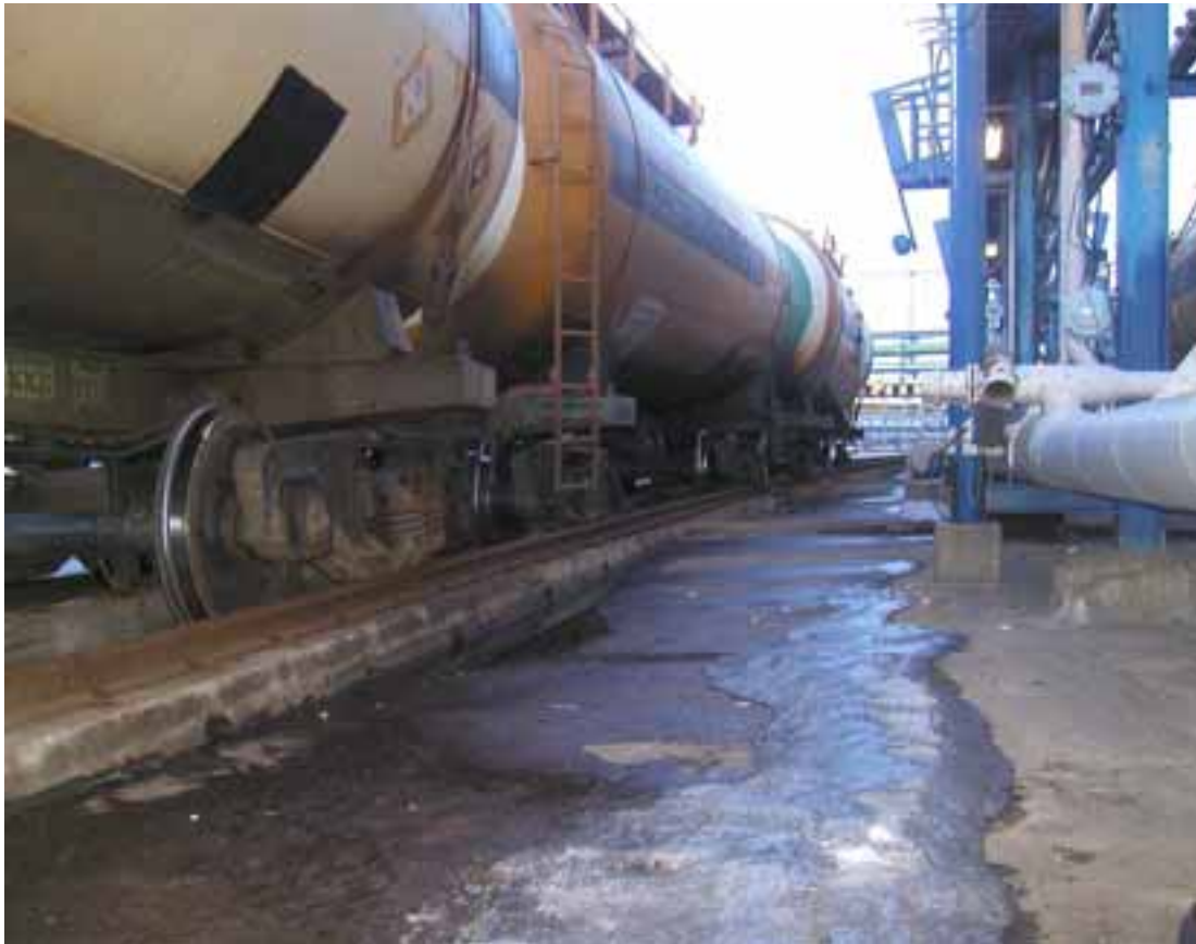
Kuva 2. Suistuneet vaunut purkuraiteella.
