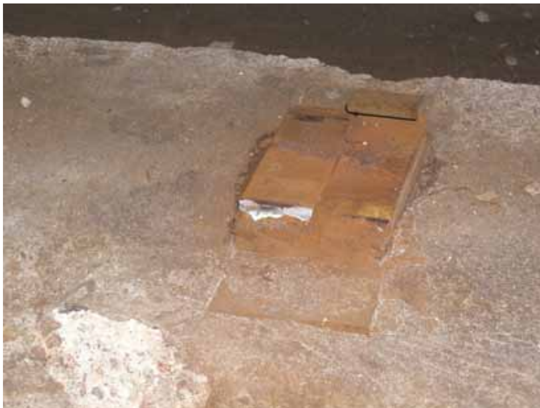
Kuva 4. Kiskon kiinnityksen j-kiinnikkeen ulkokaarteen puoleinen rauta on irronnut hitsauksesta.
