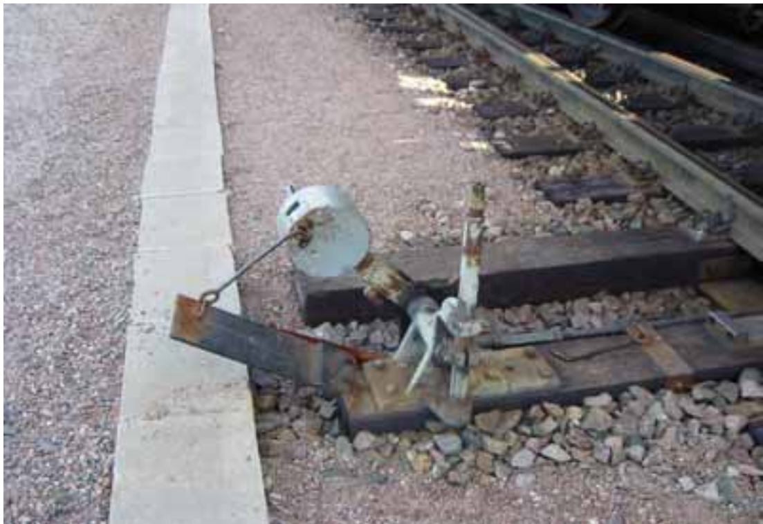
Kuva 3. Veturilla työnnettyjen dieselöljywaunujen törmääminen butaanivaunuun Sköldvikissä 1.10.2002. Vaihteen aukiajossa vioittunut vaihteenasettimen varmistukseen tukirauta.
