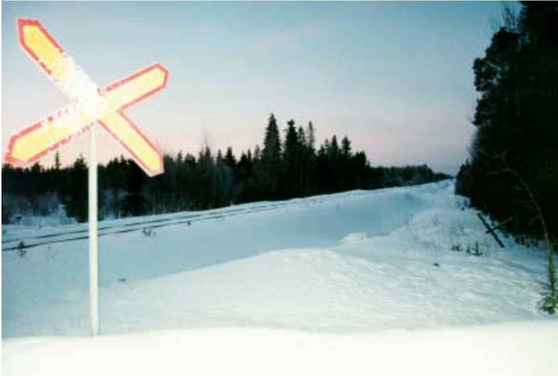
Kuva 7. Onnettomuus lissä Akolan vartioimattomassa tasoristeyksessä 9.2.2000. Näkymä auton tulosuunnasta junan tulosuuntaan.
