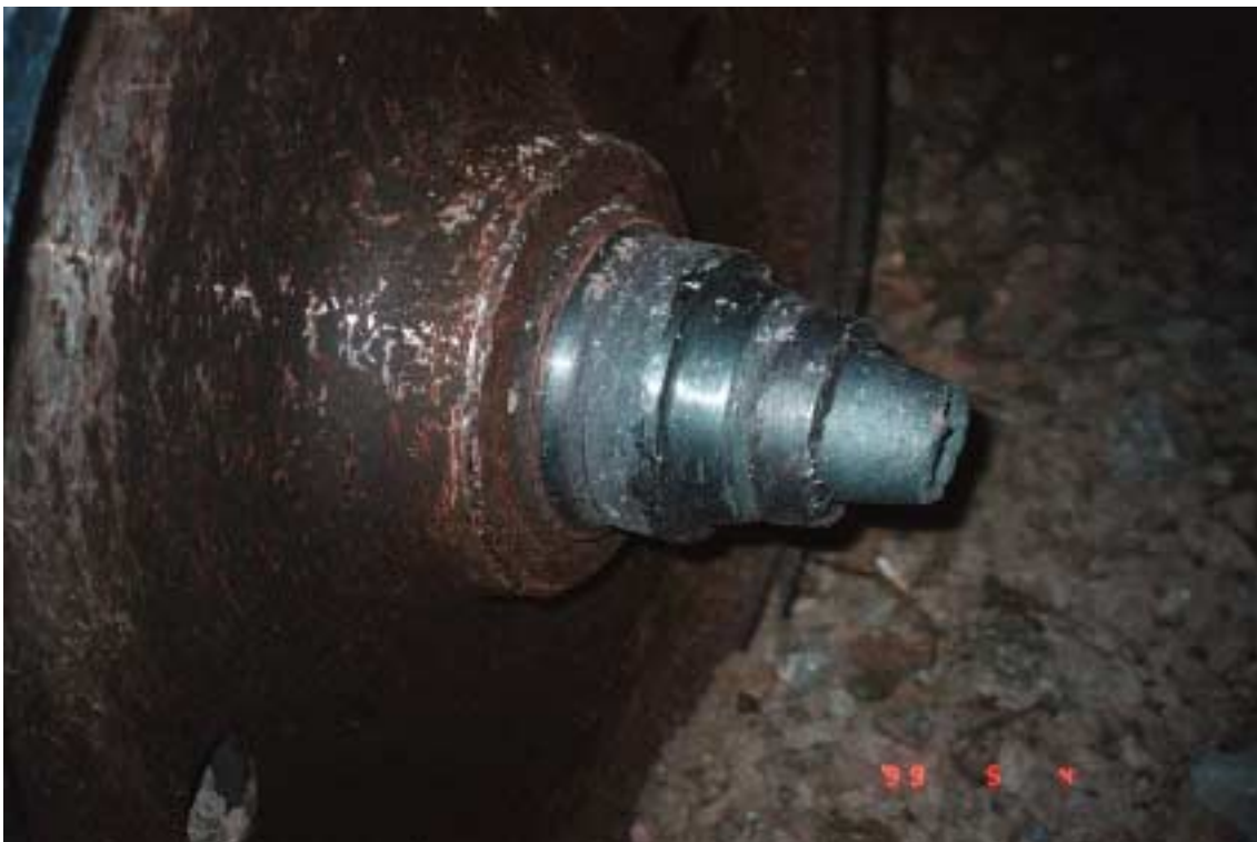
Kuva 7. Puutavaravaunujen suistuminen Multamäellä 4.5.1999. Akselin katkennut pää. Pyörässä ei ollut lovia, eikä pyörän levyosalla ollut jäänteitä laakeripesästä mahdollisesti poistuneesta laakerirasvasta.
