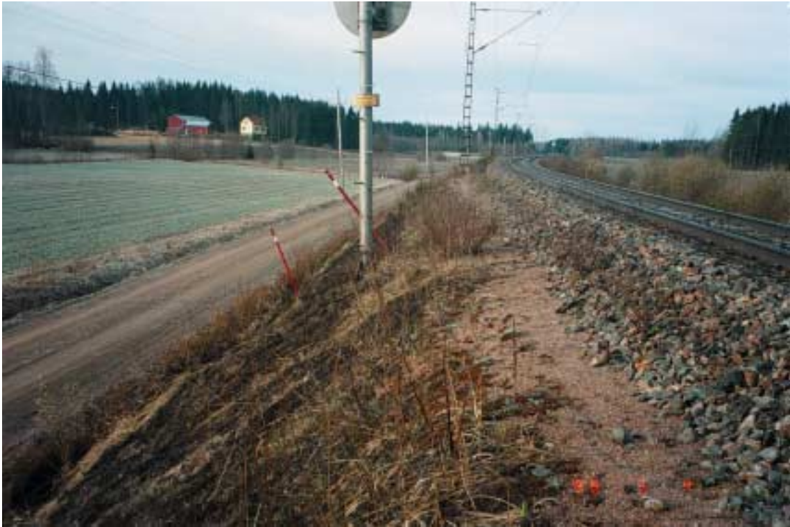
Kuva 2. Puutavaravaunujen suistuminen Multamäellä 4.5.1999. Tavarajunassa T 2258A 13. vaunun takapyöräkerran akseli katkesi Selänpään liikennepaikan eteläpuolella. Punahehkuisiksi kuumennut laakeripesä, pyöräkerran tuennan osia ja laakerirasvaa lensi ratapenkereelle sytyttäen heinikon tuleen. Heinikkoa paloi noin 50 m matkalta.
