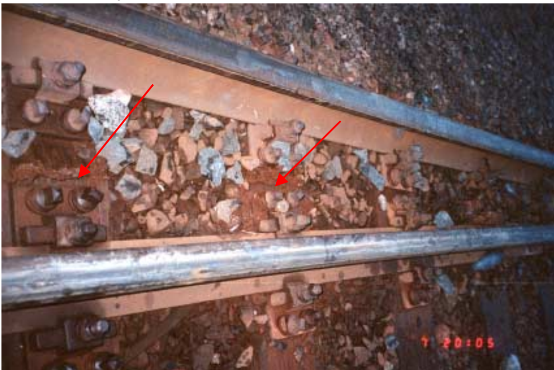
Kuva 6. Säiliövaunujen suistuminen kiskoilta ja palo Vainikkalassa 7.4.1999. Vaihteen V63 ulkokaarteeseen puoleisen kielen kiinteä osa oli siirtynyt ulospäin johtuen pehmentyneistä puisista vaihdepölkkyistä. Vaunujen siirryttyä pois oli kieli palannut lähes alkuperäiseen asentoonsa
