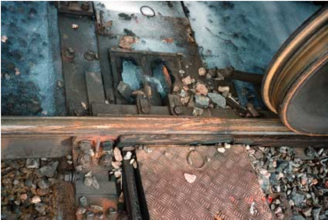
Kuva 7. Säiliövaunujen suistuminen kiskoilta ja palo Vainikkalassa 7.4.1999. Pyöränlaipan tekemiä kiskonylmenojälkiä vaihteen V63 vasemman kielen kärjen kohdalla.
