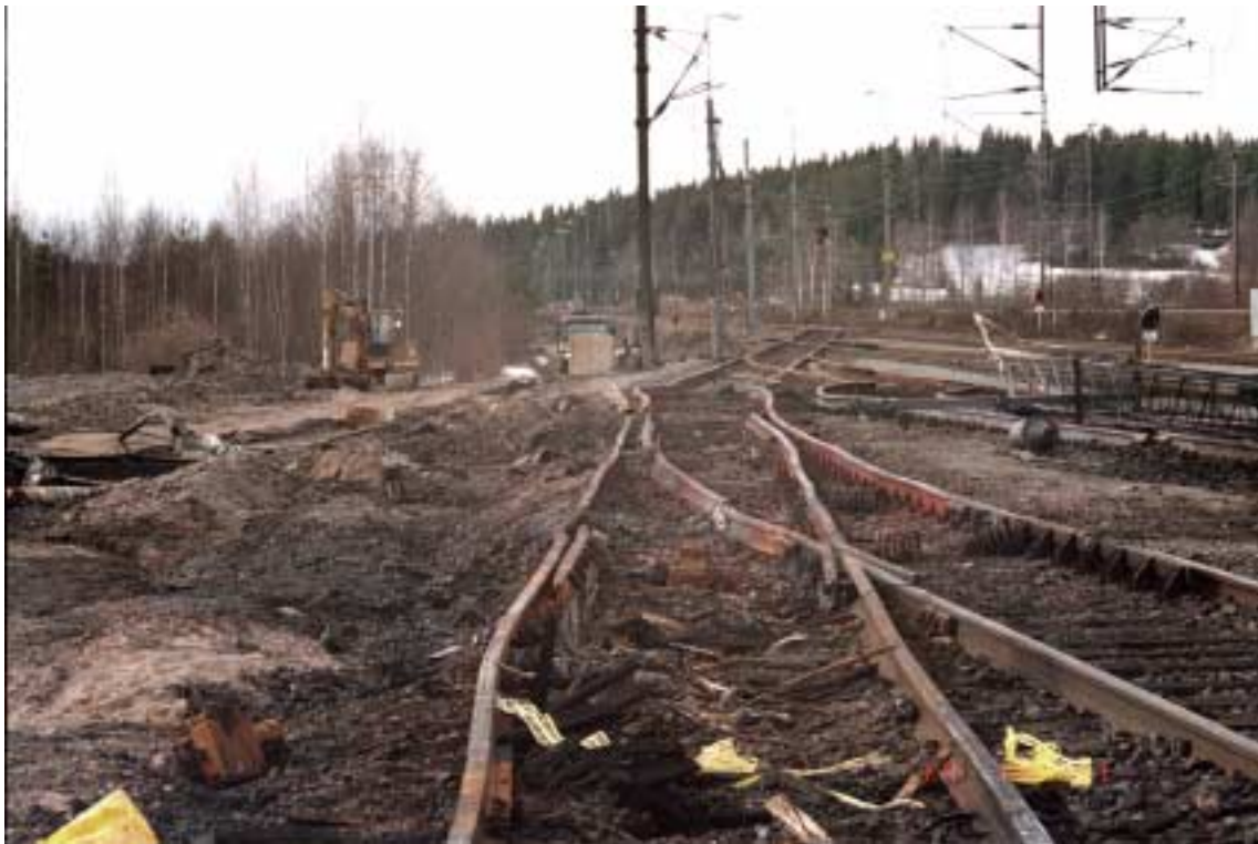
Kuva 14. Säiliövaunujen suistuminen kiskoilta ja palo Vainikkalassa 7.4.1999. Ratavaurioita edellistä kuvaa hiukan lähempää kuvattuna.
