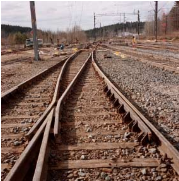
Kuva 13. Säiliövaunujen suistuminen kiskoilta ja palo Vainikkalassa 7.4.1999. Vaunut ja telit on viety pois. Kuva on otettu seisten ensimmäisellä uudella ratapölkkyllä. Suistuminen alkoi oikealla kiskolla näkyvien raideruuvien kohdalta.
