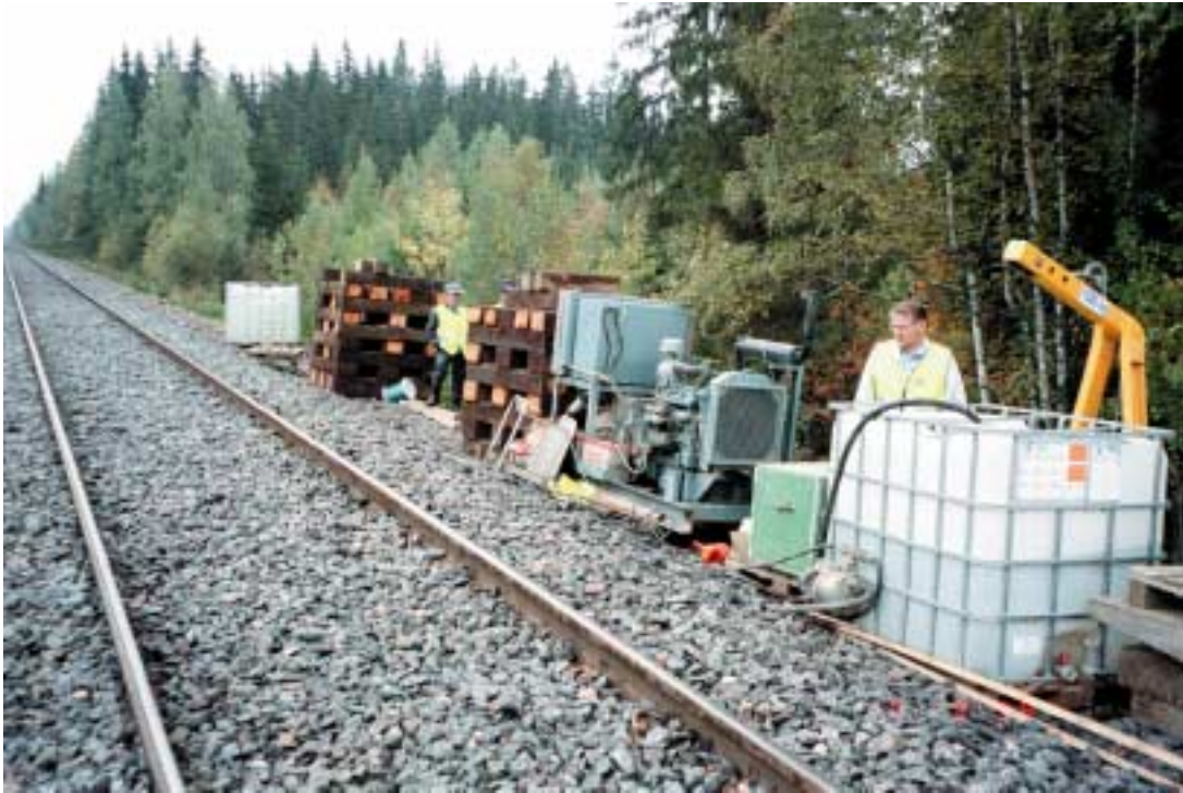
Kuva 2. Työmiehen jääminen henkilöjunan veturin alle Varkaudessa 14.9.1998. Työmaan laitteet ja tarvikkeet oli sijoitettu osittain jopa aukean tilan ulottuman (ATU) sisäpuolelle. Vesisäiliön vieressä on vihreä työkalulaatikko.
