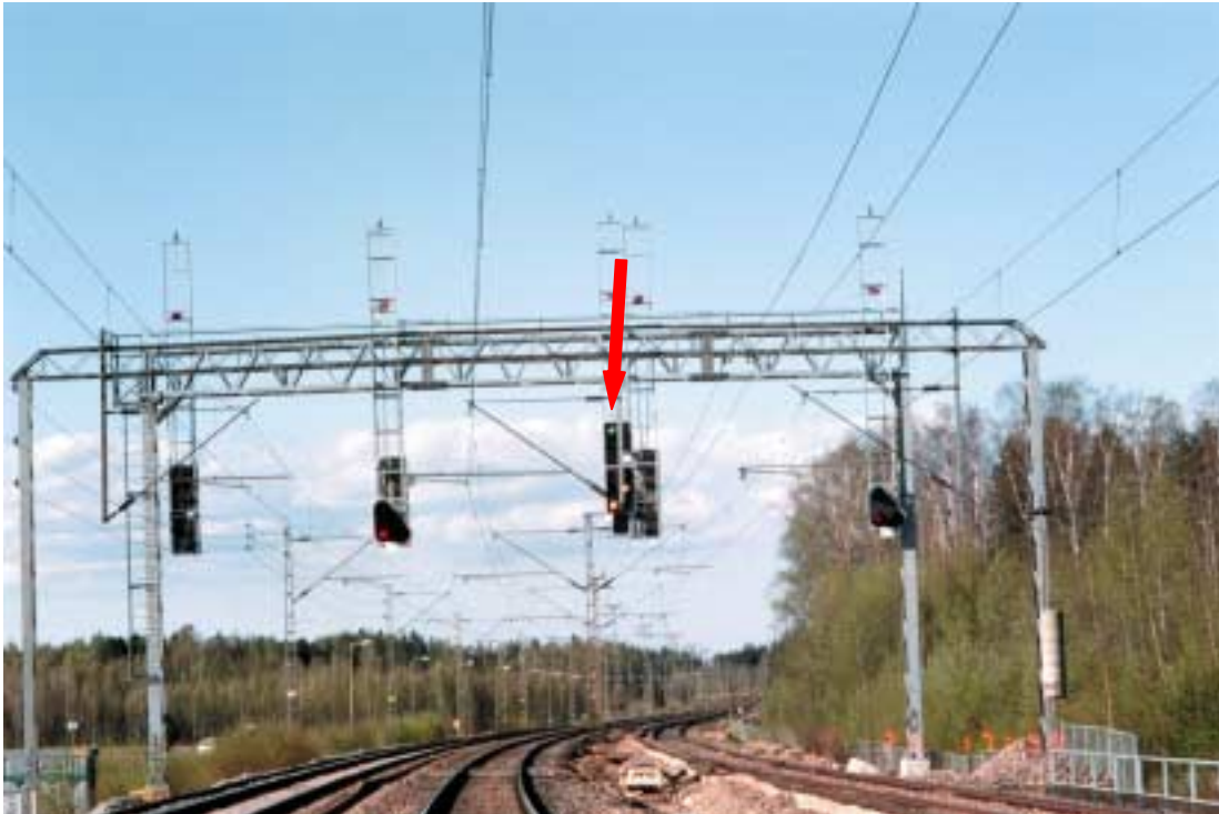
Kuva 2. Korson lähtösuunnan pääopastin P 442 ("aja"-opaste) ja sen alapuolella Savion tulosuunnan pääopastimen esiopastin, jossa "odota seis"-opaste.
