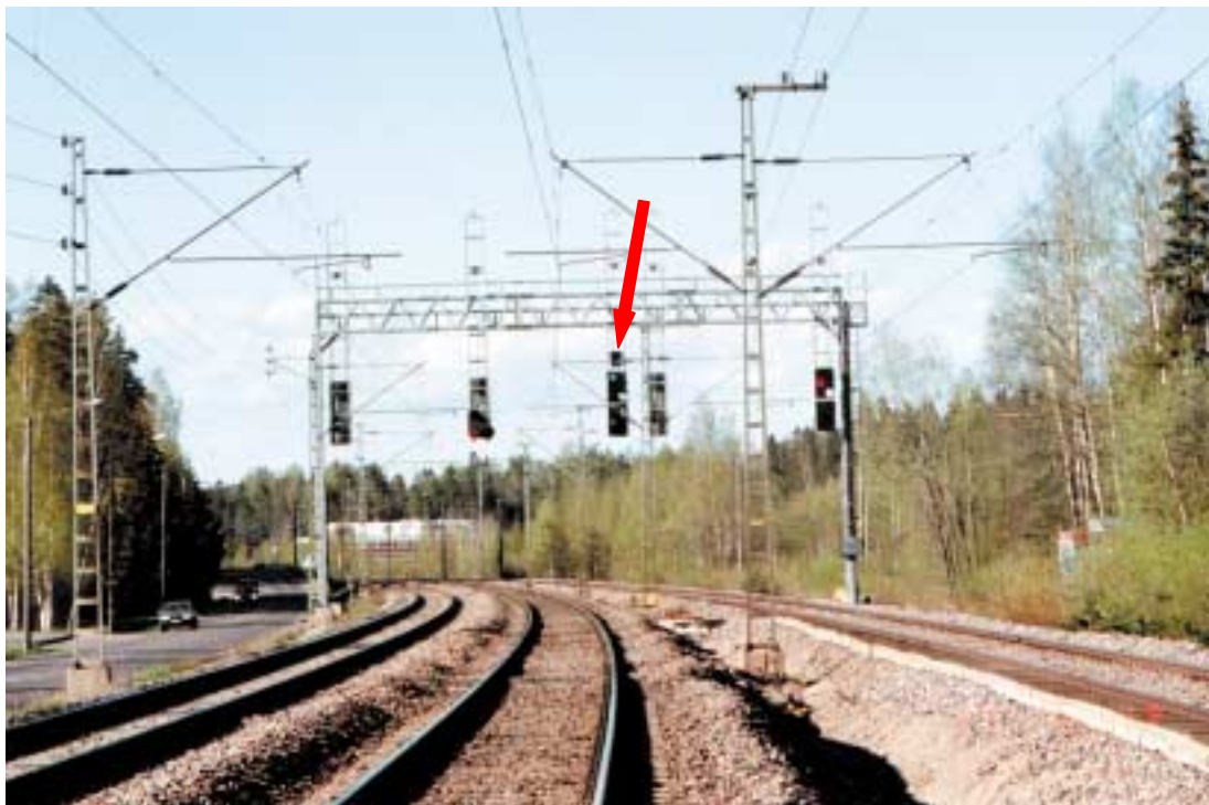
Kuva 3. Savion tulosuunnan pääopastin P 462 ("aja"-opaste) ja sen alapuolella lähtösuunnan pääopastimen esiopastin ("odota aja"-opaste).
