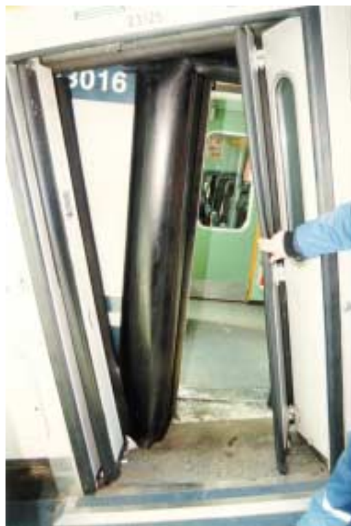
Kuva 14. Jyväskylän junaonnettomuus 6.3.1998. Vaunujen päädyissä olevat ovet vaurioituivat onnettomuudessa niin, ettei niitä saanut auki kuin väkivalloin. Vaunujen kallistuminen esti myös siirtymisen vaunusta toiseen.
