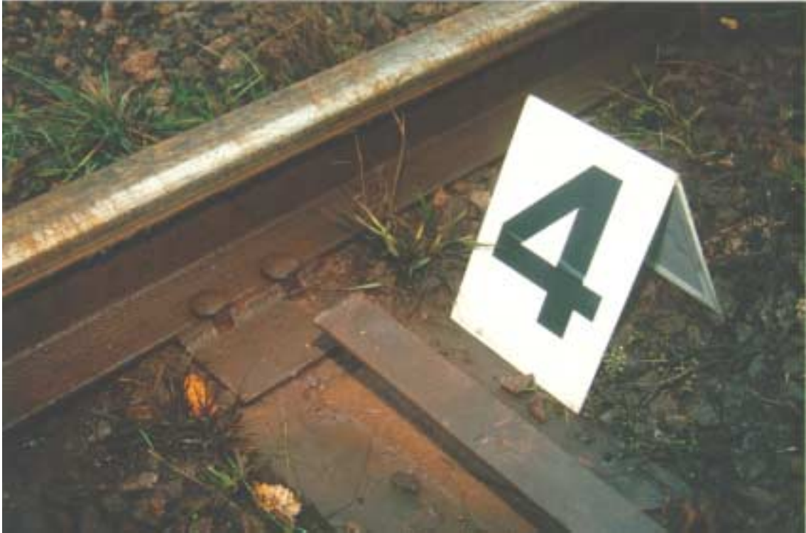
Kuva 5. C18/1996 R 4.11.96 Uusikaupunki Kemira Agro Oy:n tehtaat. Rataa on tuettu rakentamismääräyksiin ja ohjeisiin kuulumattomalla tuennalla. Aluslevy ei voi hitsata kuvan lattarautaan siten, että hitsaus kestäisi.
