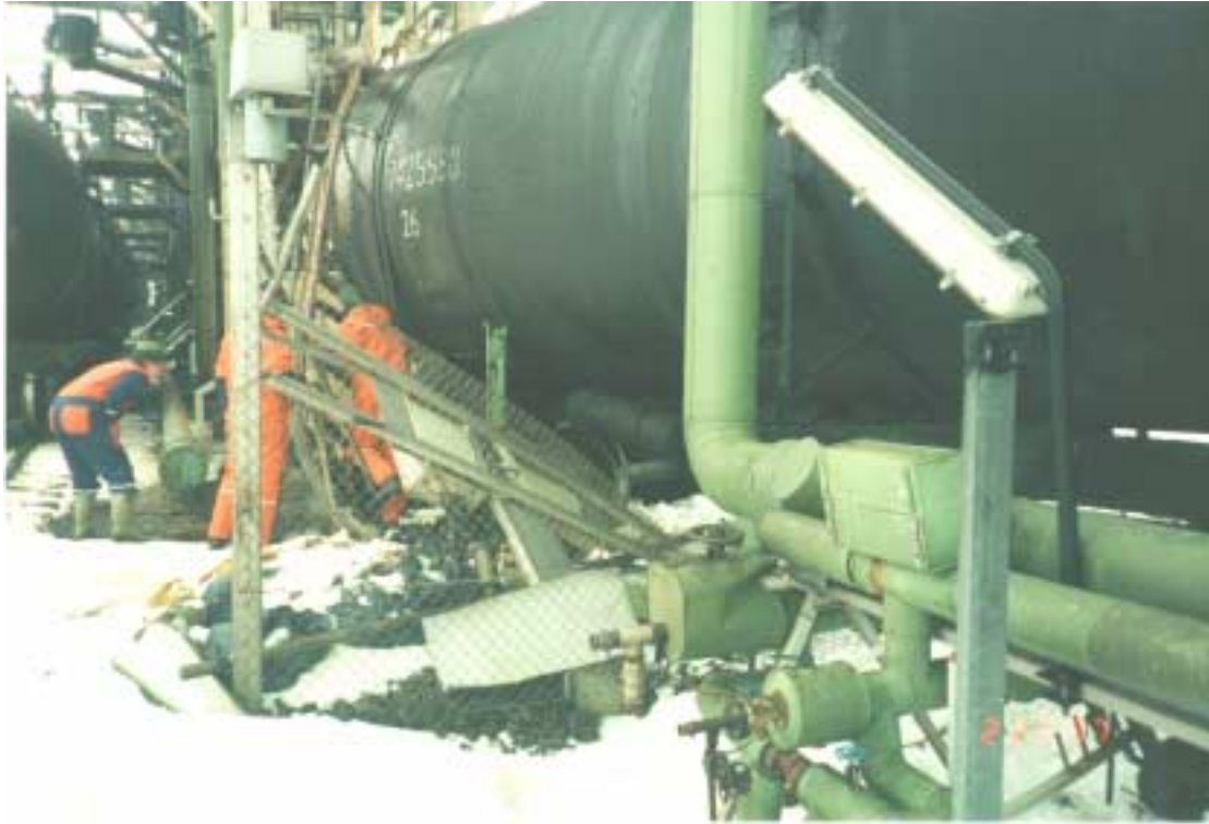
Kuva 15. C8/1997 R 23.2.97 Haminan ratapiha Neste Oy:n raiteisto. Suistuvat vaunut tuhosivat lastaus- ja purkauspaikan rakenteita. Kemikaalien siirtoon tarkoitetut putkistot olivat vähällä vaurioitua.
