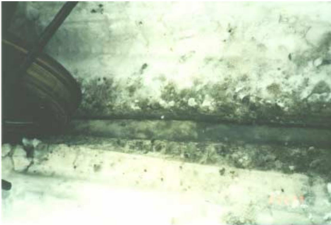
Kuva 16. C8/1997 R Haminan ratapiha Neste Oy:n raiteisto. Talvikunnossapidon laiminlyönti aiheutti vaunujen suistumisen. Lumi pakkautui vaunun pyörän alla paikoin jopa sentin paksuiseksi jääkerrokseksi.
