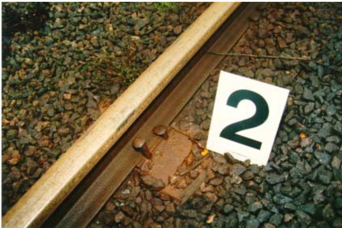
Kuva 4. C18/1996 R 4.11.96 Uusikaupunki Kemira Agro Oy:n tehtaat. Kiskojen naulaus on löystynyt . Puuratapölkkyjen kunto oli kohtuullisen hyvä.
