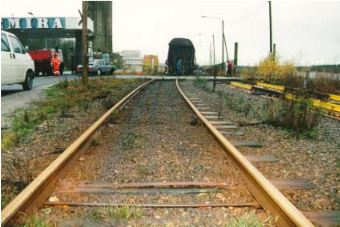
Kuva 3. C18/1996 R 4.11.96 Uusikaupunki Kemira Agro Oy:n tehtaat. Lannoitelastissa ollut venäläinen tavaravaunu suistui kiskoilta Kemira Agro Oy:n pääportin kohdalla kiskojen huonon kiinnityksen vuoksi.
