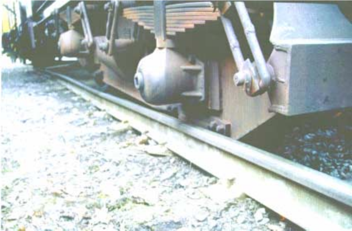
Kuva 17. C15/1997 R 9.5.97 Kuusankoski UPM- Kymmene Oy:n tehtaat. Radan leviäminen aiheutti kloorivaunun etutelin suistumisen. Leviäminen on kuvassa silmin- nähtävien havaittavissa.
