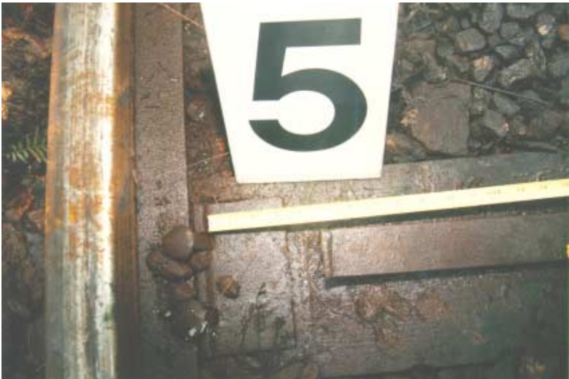
Kuva 6. C18/1996 R 4.11.96 Uusikaupunki Kemira Agro Oy:n tehtaat. Virheellisen tuennan hitsisauma on irronnut kauan sitten. Rata on levinnyt ulkokaarteen puolelle noin 20 mm. Radan raideleveys oli kuitenkin vielä sallituissa raja-arvoissa.
