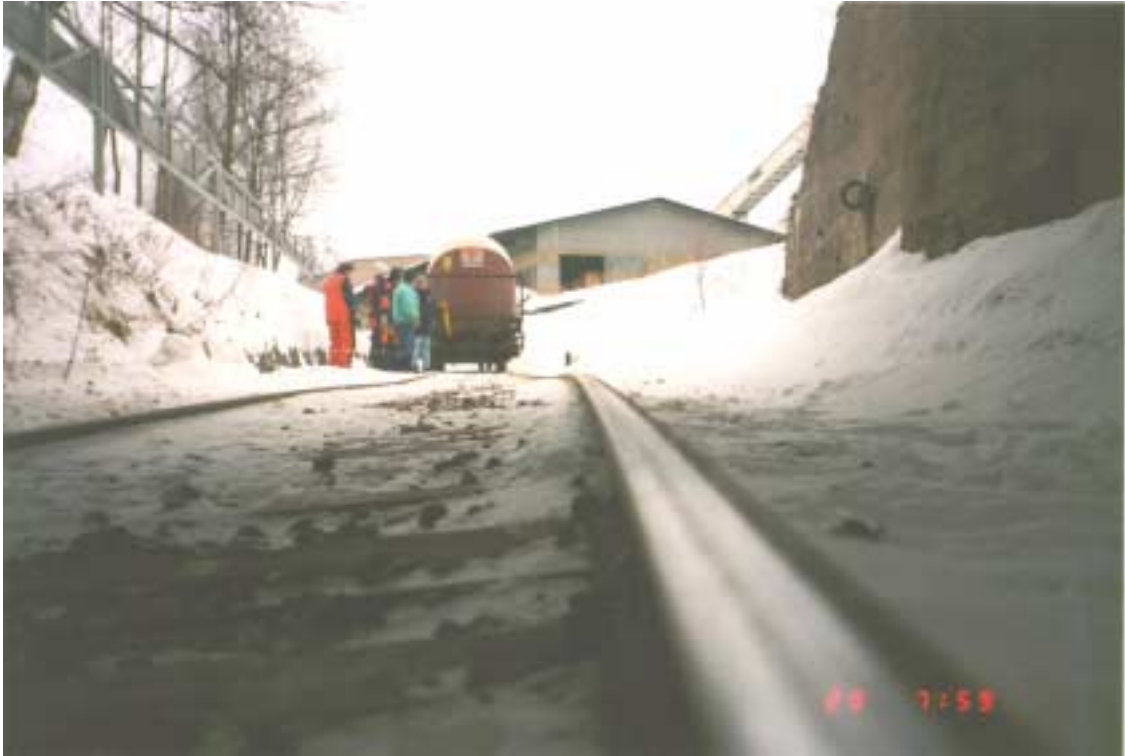
Kuva 11. C6/1997 R 16.2. ja 19.2.97 Kuusankoski UPM- Kymmene Oy:n tehtaat. Tyhjä kloorivaunu suistui kiskoilta voimakkaasti "aaltoilevalta" radalta. Radan rakenteisiin pääsevä vesi ei pääse poistumaan rakenteista.
