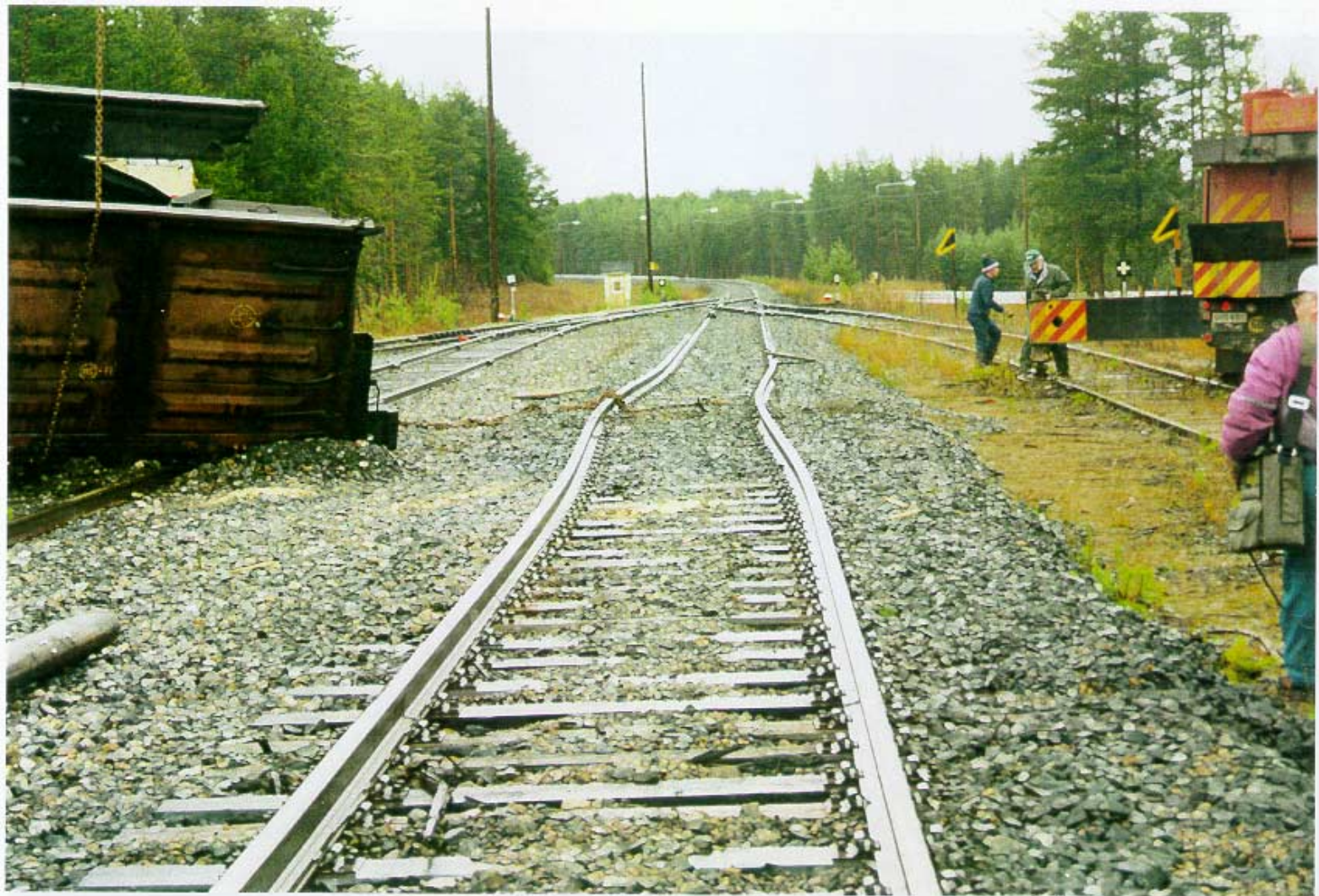
Kuva 6. Pääraitteeseen syntynyt mutka.
