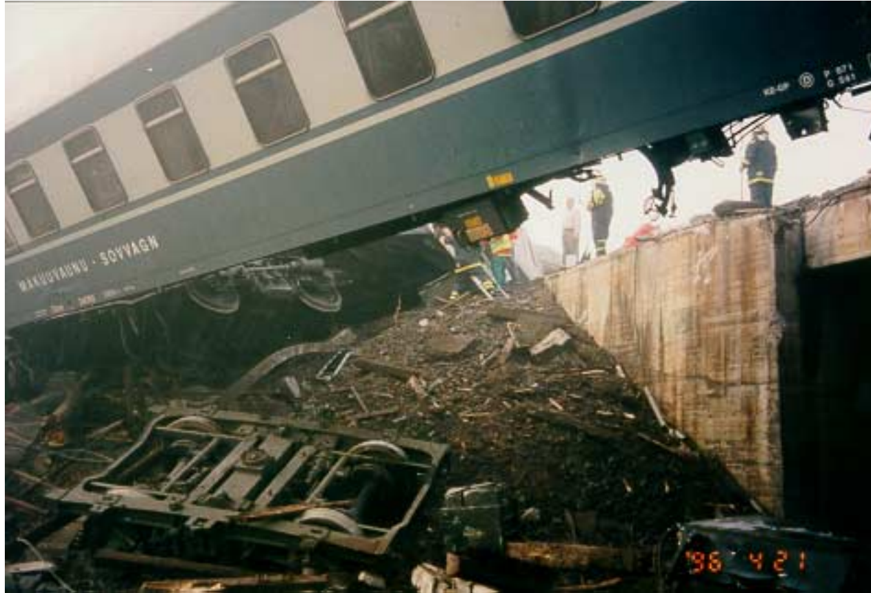
Kuva 8. Kuudentena ollut makuuvaunu jäi roikkumaan alikulkusillan päälle. Tässä vaunussa kukaan ei loukkaantunut vakavasti, mutta useat matkustajat jäivät loukkuun makuuvaunuosastoonsa, koska hyttien ovet eivät avautuneet.
