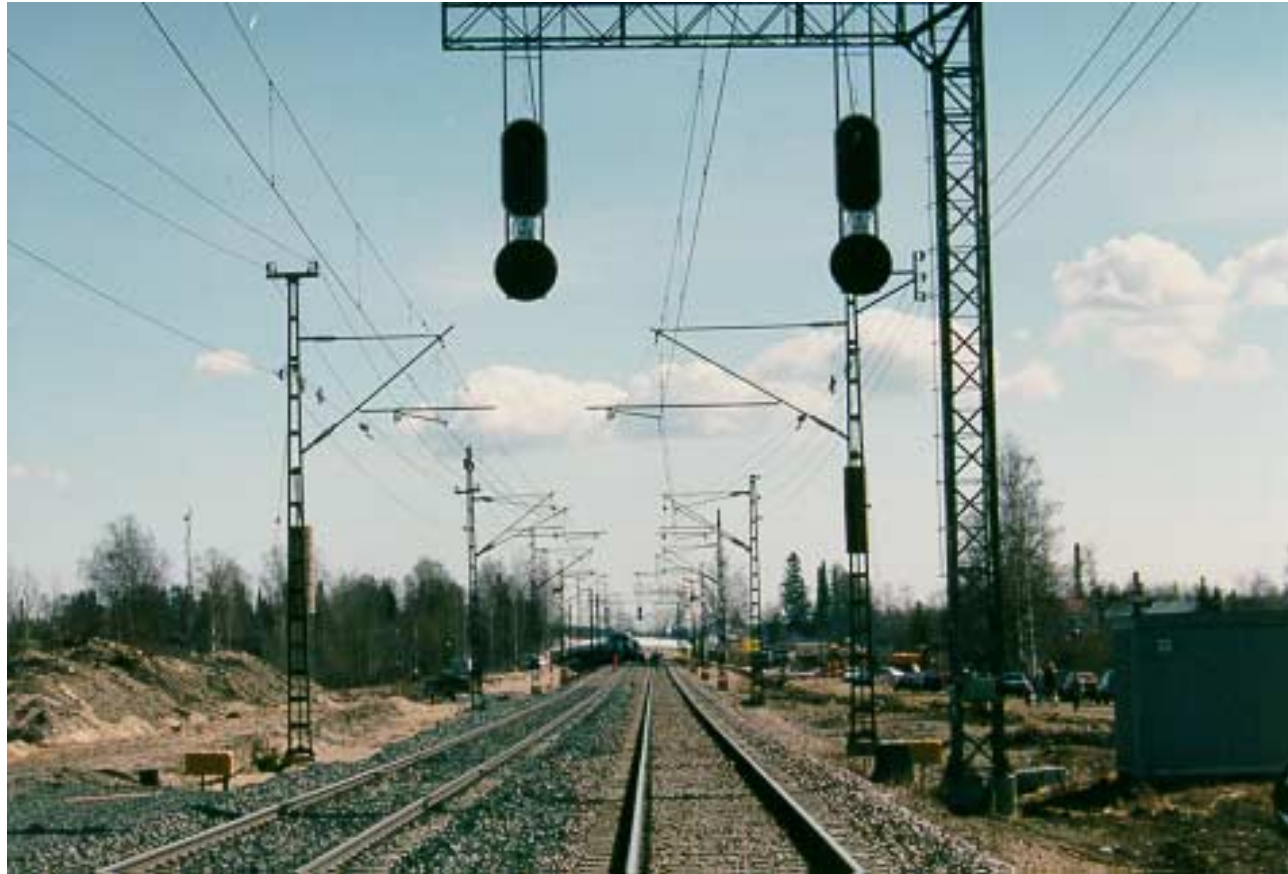
Kuva 1. Onnettomuusjuna tuli sakeassa sumussa 133 km/h nopeudella kuvan pääopastimelle, jonka vihreä ja keltainen valo ilmoittivat 300 metrin päässä olevan vaihteen, jossa suurin sallittu nopeus oli 35 km/h. Pääopastimella veturinkuljettaja teki hätäjarrutuksen.
