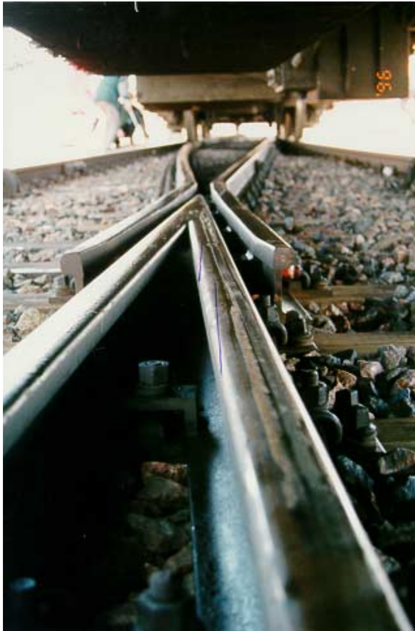
Kuva 2. Veturin takateli suistui vaihteessa raiteilta nopeudessa 124 km/h (jäljet vahvistettu kuvaan) ja veturi kääntyi tulosuuntaansa kaatuen ratapenkereelle. Yhdestoista vaunusta kolme viimeistä pysyi kiskoilla.
