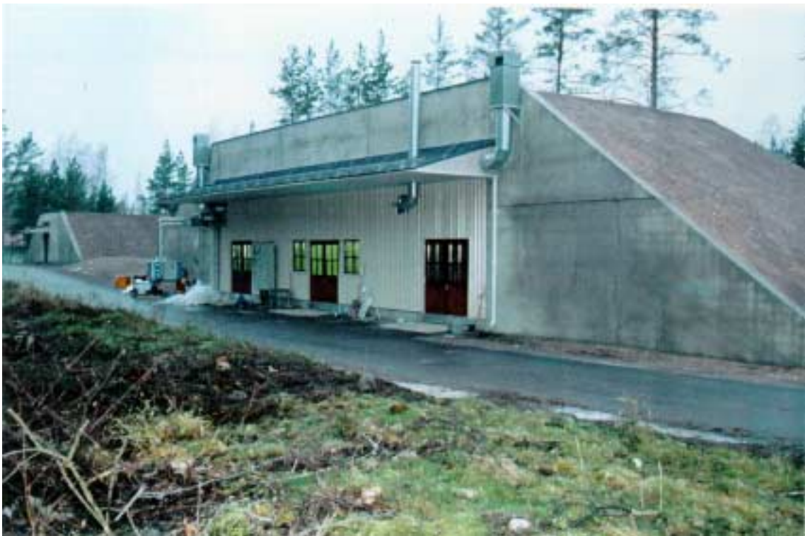
Rakennus nro 92. FPX-yksikön sekoittamo. Kuvattu korjauksen jälkeen.
