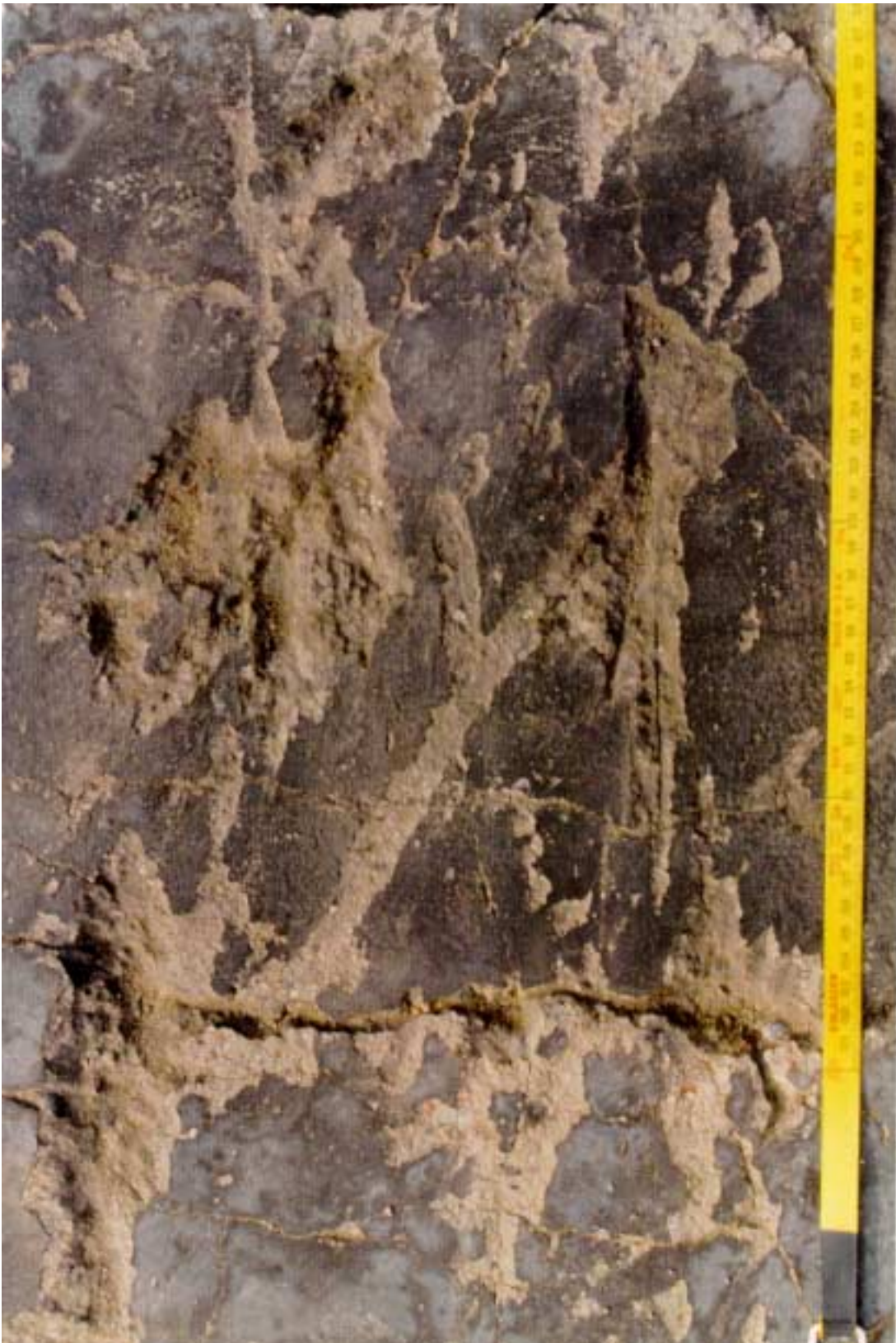
Lähikuva tuhoutuneen jälkikäsitteilylaitoksen lattiassa olevista iskemäjäljistä.
