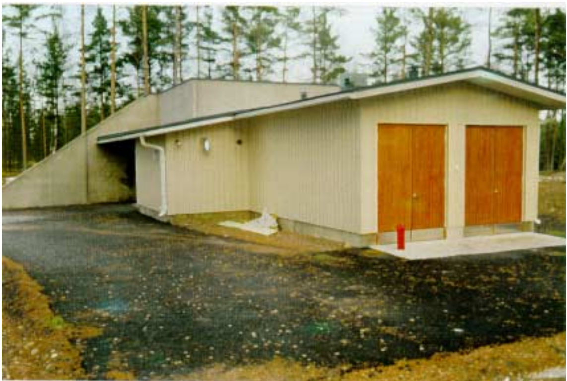
Rakennus nro 93. FPX-yksikön jälkikäsittelylaitos.
