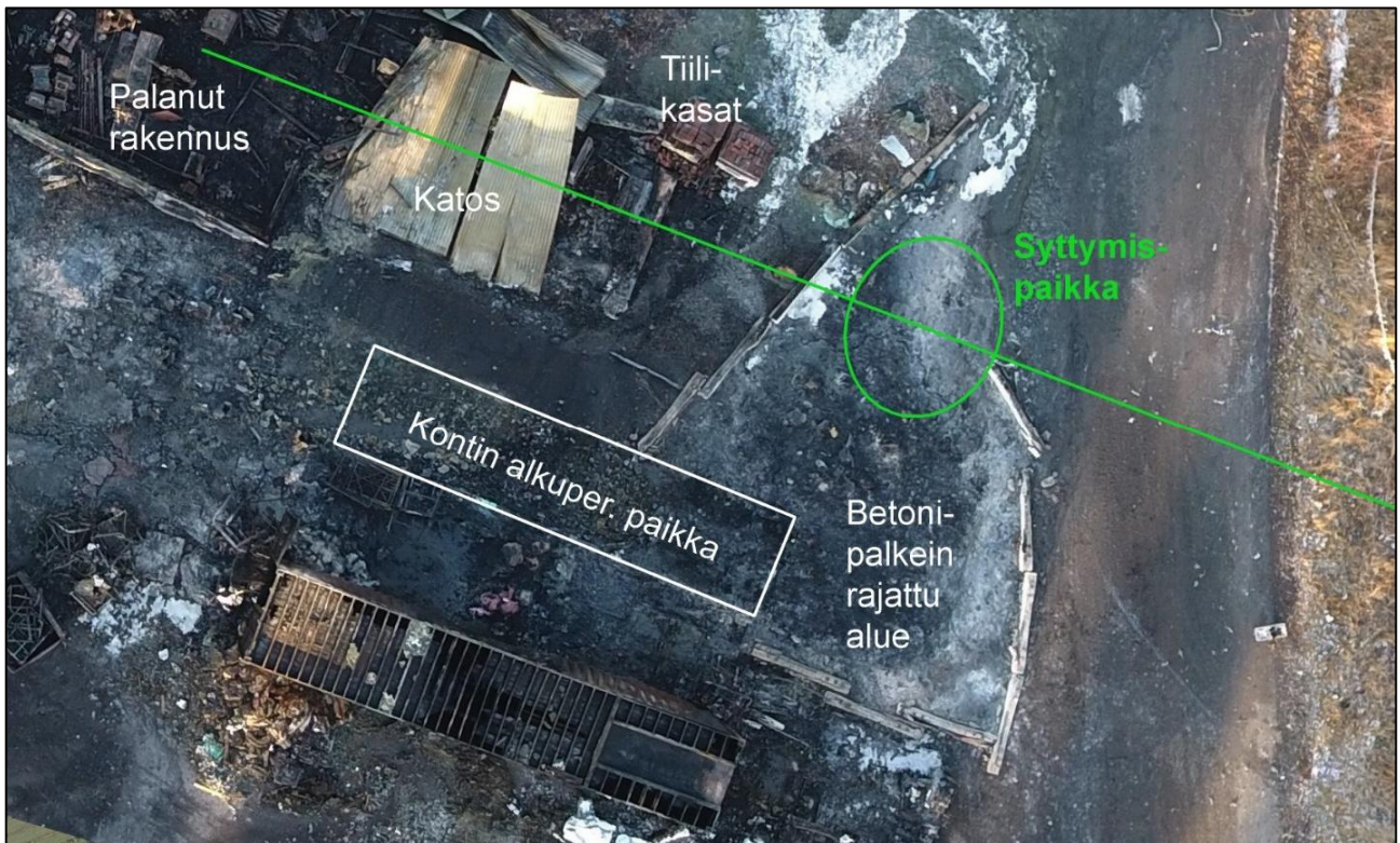
Kuva 13. Yhdistämällä kuvien 10 ja 11 tieto saadaan syttymispaikaksi betonipalkein rajatulle alueelle johtava kulkuaukko. (Ilmakuva: poliisi. Piirros: OTKES.)
