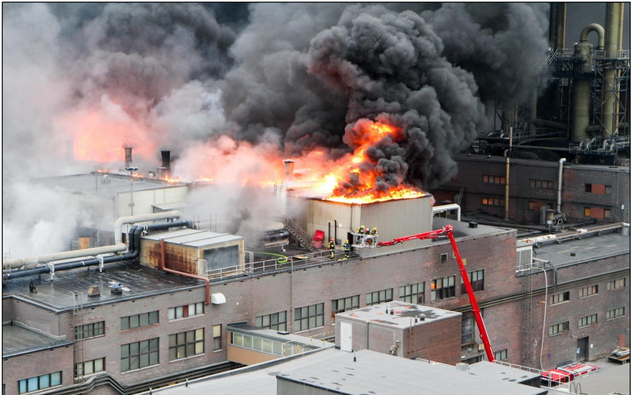
Kuva 16. Tilanne katolla kello 11.47. Kuva on otettu viereisen voimalaitoksen katolta. Nostolavan vieressä oleva rakennuksen palava osa on 23 m korkea. (Kuva: poliisi.)
