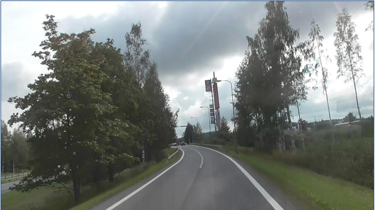
Bild 11. De träd som under årens lopp växt mellan motorvägen och rampen täckte sikten mot korsningen. Avståndet från det plats varifrån bilden tagits till korsningen är 130 meter. Till skillnad från bilden ska det beaktas att chauffören sitter i vänstra kanten av fordonet. Andra bilder från ingången finns i bilaga 1. (Bild: Polisen)
