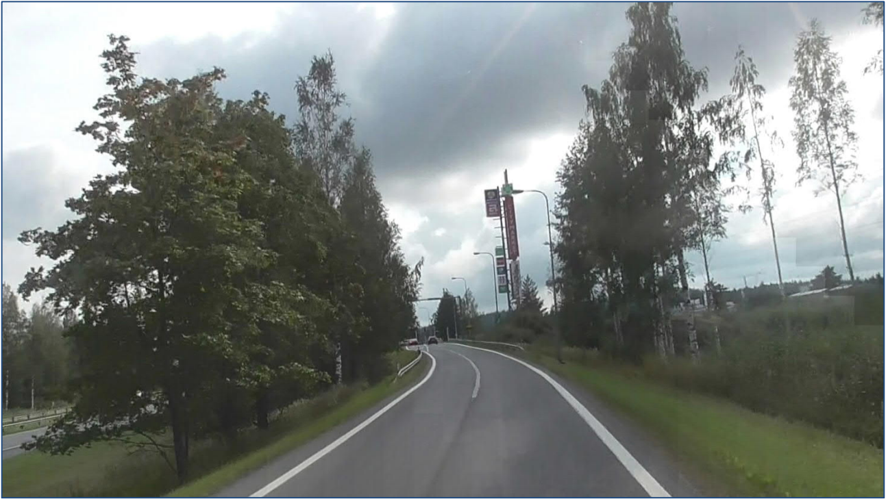
Kuva 11. Moottoritien ja rampin välissä vuosien varrella kasvaneet puut peittivät näkemää risteykseen. Kuvan ottopaikasta on risteykseen 130 metriä. Kuvasta poiketen on otettava huomioon, että kuljettaja istuu ajoneuvon vasemmassa reunassa. Muita lähestymiskuvia on liitteessä 1. (Kuva: Poliisi)
