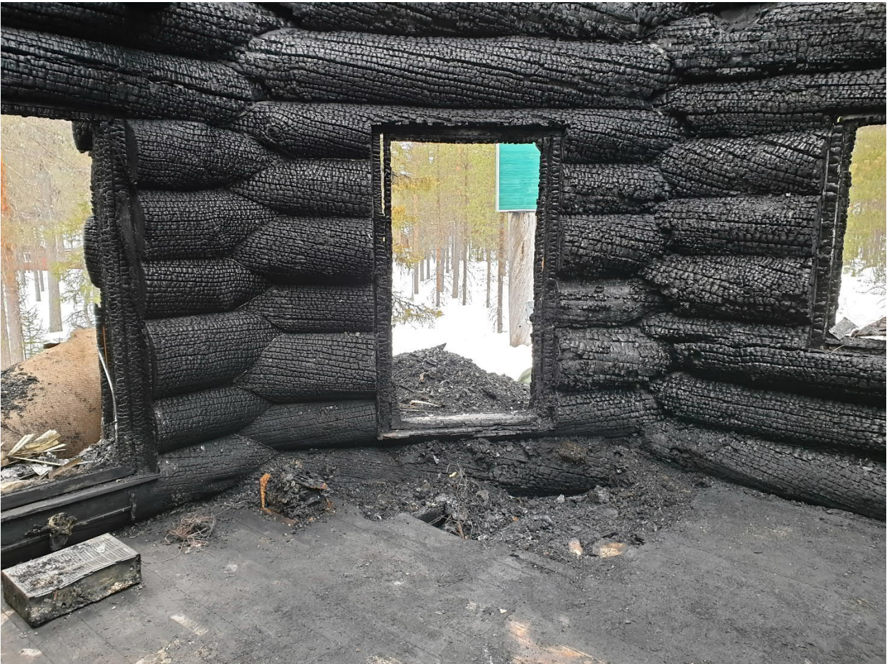
Kuva 3. Syttymispaikka olohuoneessa puhdistettuna. (Kuva: OTKES)
