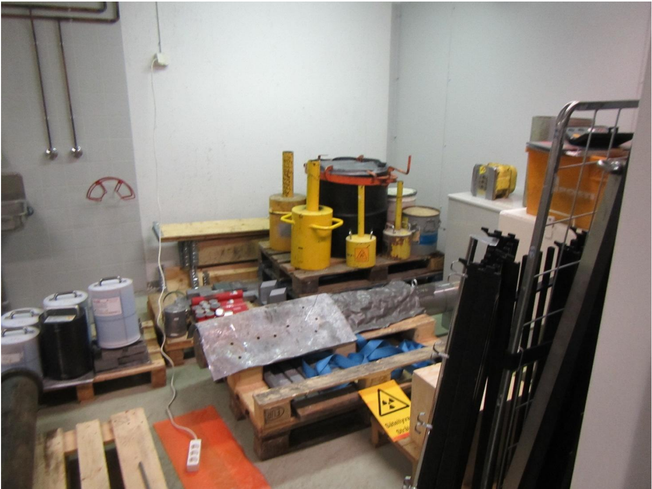
Kuva 11. Purettujen säteilylähteiden varasto, huone C. (Kuva: STUK)
