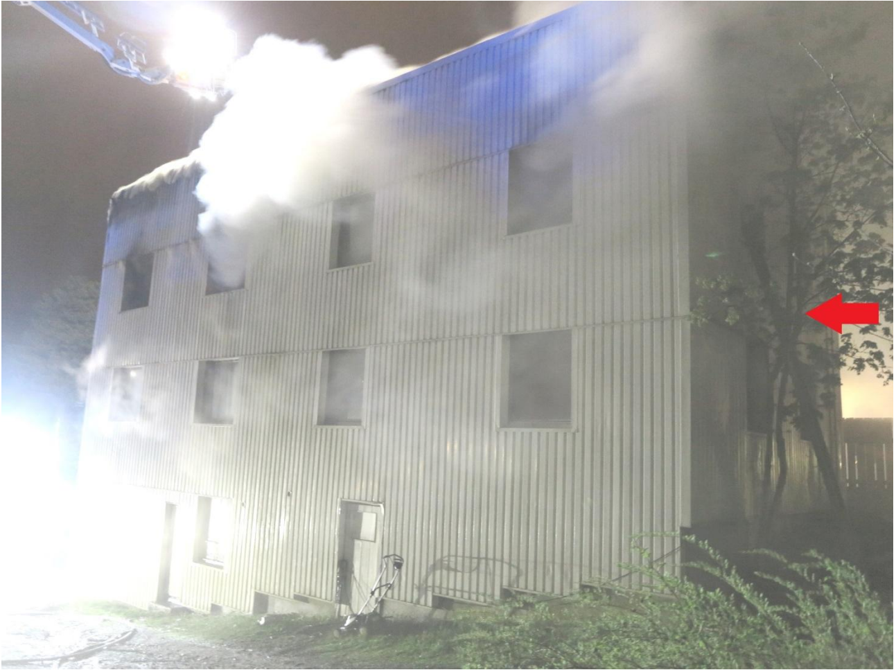
Kuva 2. Kuvassa näkyy ulkopuolisten henkilöiden käyttämät irtotikkaat rakennuksen takaseinällä. Kuva: Varsinais-Suomen pelastuslaitos.
