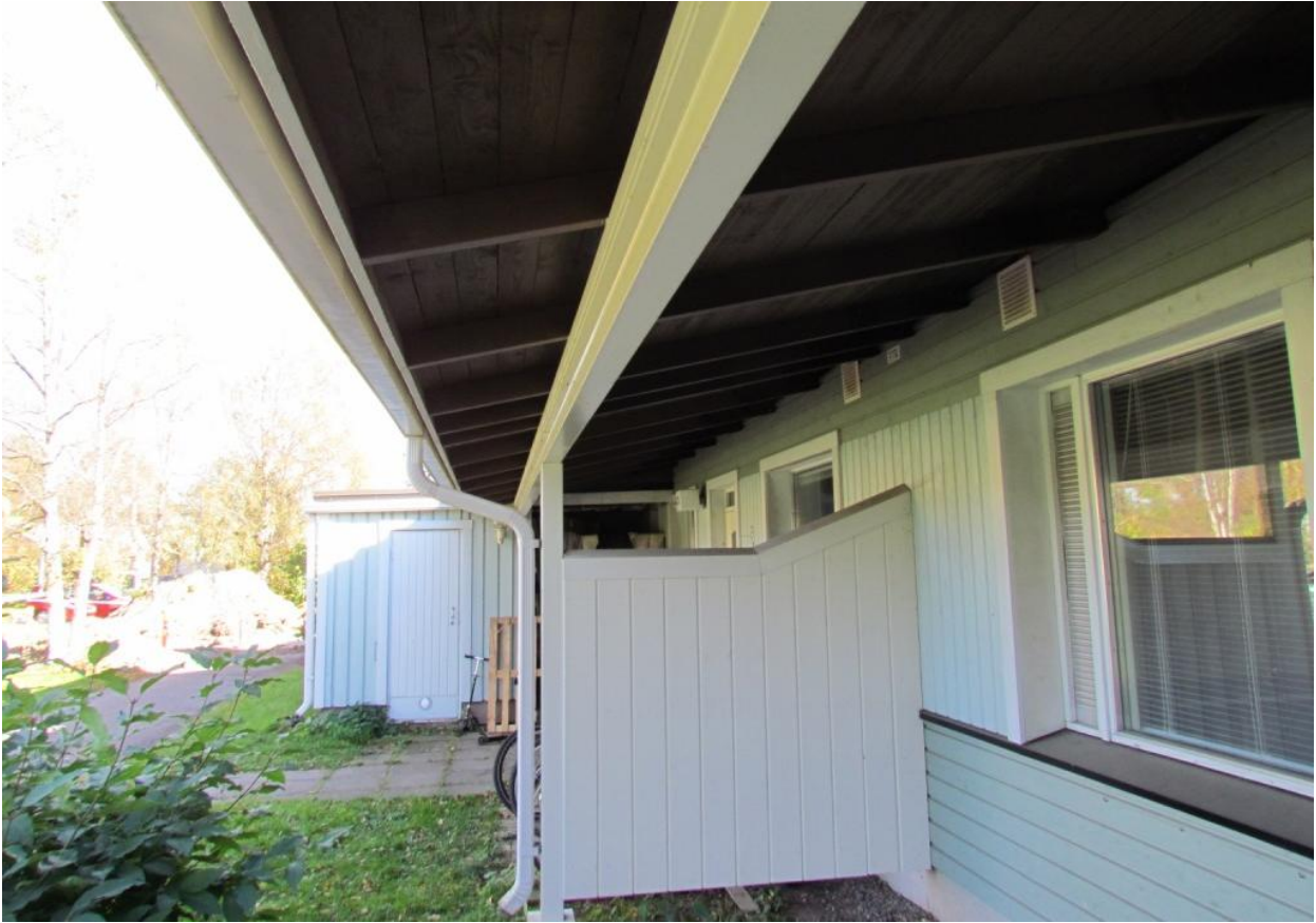
Kuva 3. Samanlainen räystääs taloyhtiön toisessa rakennuksessa. (Kuva: OTKES)
