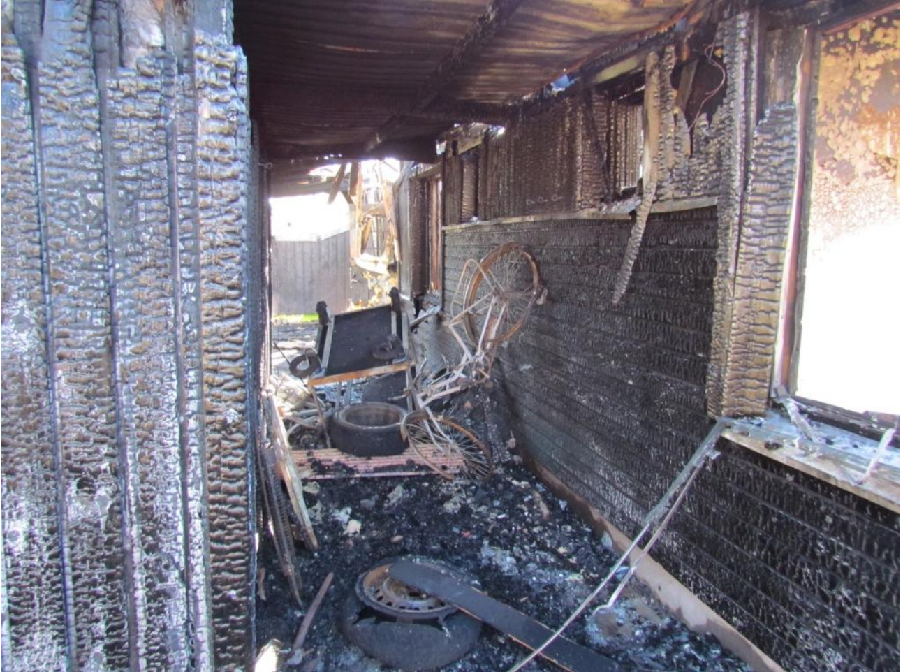
Kuva 2. Palanut talon julkisivu. Pidennetty räystäs ja varastot muodostivat suotuisat olosuhteet palon leviämislle huoneistosta toiseen. (Kuva: OTKES)
