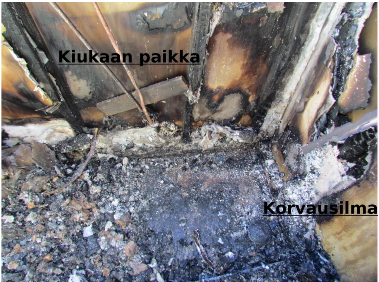
Kuva 8. Palojäljet saunassa. Palo sai ilmaa korvausilmaventtiilistä. (Kuva. OTKES)
