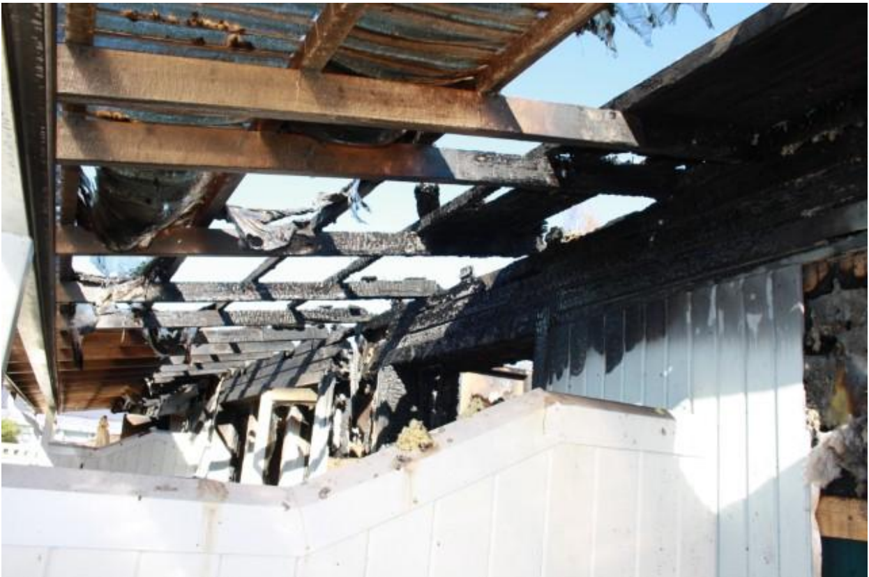
Kuva 4. Kuva talon takapihalta syttymishuoneiston kohdalta. Valokate oli sulanut ja päästänyt palokaasut läpi. (Kuva: OTKES)
