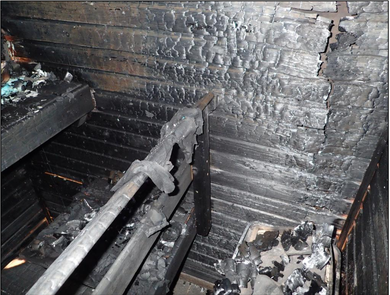
Kuva 1. Kiukaan kaiteilla oli kuivumassa olevia vaatteita ja lauteilla varastoitua tavaraa. Saunan seinä- ja kattopaneelit hiiltyivät tulipalossa ja paloivat osittain puhki. (Kuva: OTKES)
