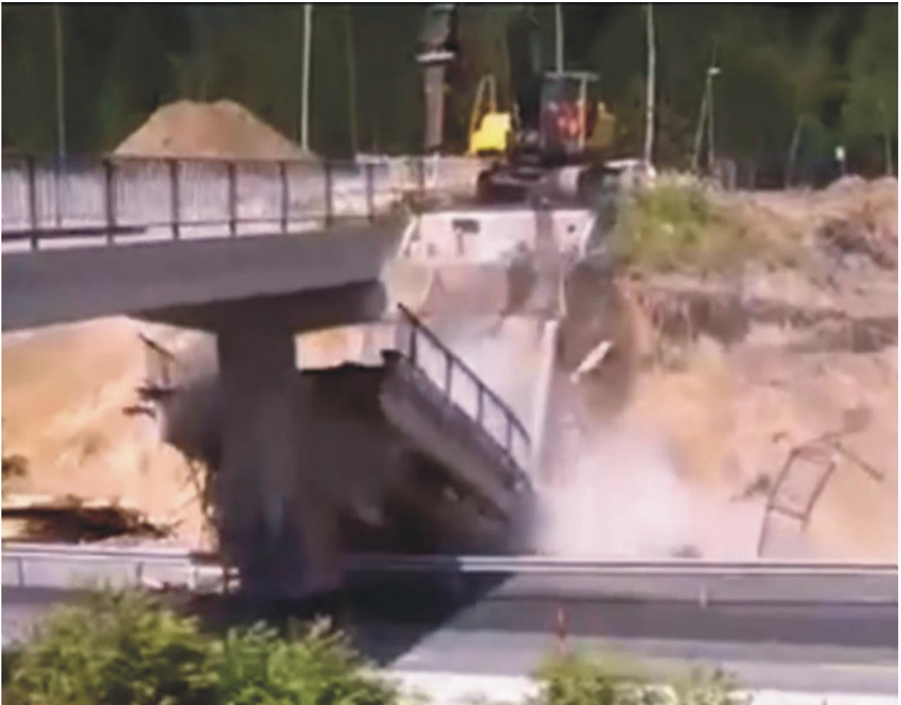
Kuva 11. Pilarin murtumistapa (Kuva: Ulkopuolinen kuvaaja)
