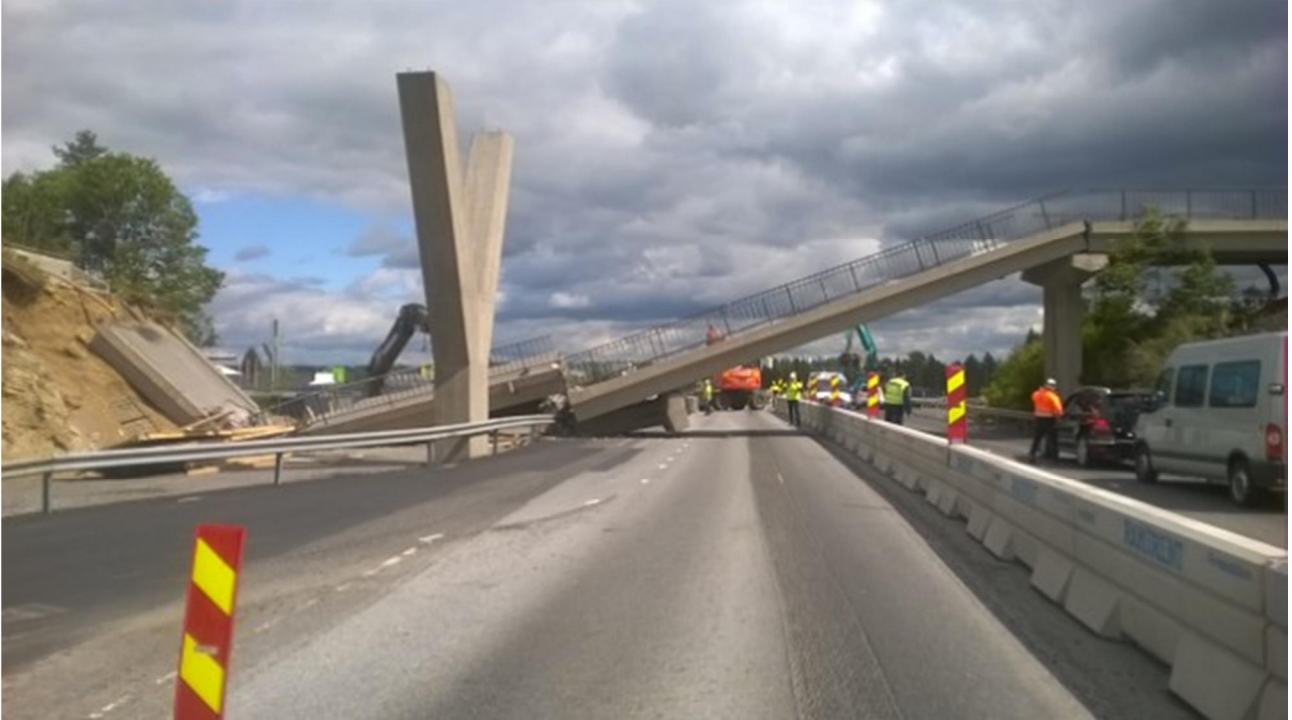
Kuva 5. Sillan kolmannen aukon kansi pysyi alkuperäisellä paikallaan pilarin ja maatuen varassa (oikealla). Sortuneen sillan etupuolelle näkyvä Y:n muotoinen pilari on pystytetty uutta sil- taa varten. Oikealla olevat autot ovat Rinnekadulla ja valtatie on vasemmalla. (Kuva: Pää- urakoitsija)
