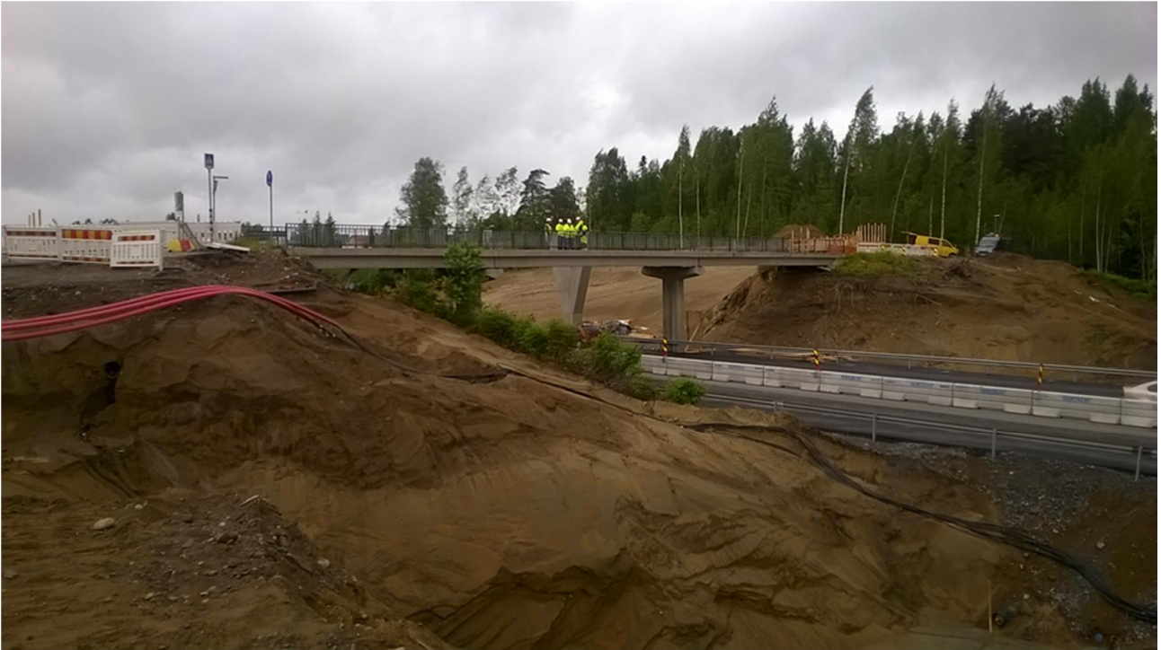
Kuva 4. Silta ennen purkutyön alkua. (Kuva: Pääurakoitsija)
