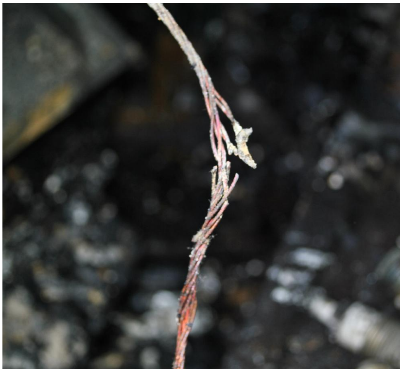
Kuva 6. Oikosulkujälki sulakekeskuksen johtimessa, joka ei ole palanut kokonaan poikki. (Kuva: OTKES)
