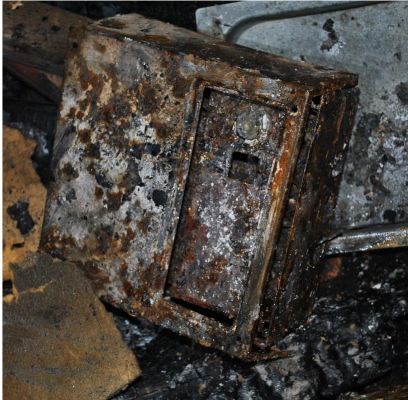
Kuva 5. Kiukaan ohjausyksikkö oli pahoin palaneessa kohdassa pukuhuoneessa. (Kuva: OTKES)
