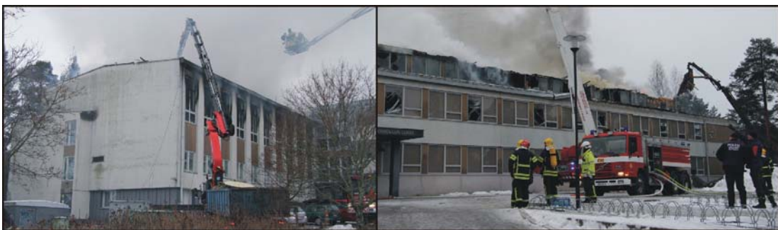
Kuva 8. Peltikaton alla edenneen palon sammutus oli haastavaa. Kattopeltejä purettiin korkeapuomisilla nosturiautoilla. (Kuvat: poliisi)
