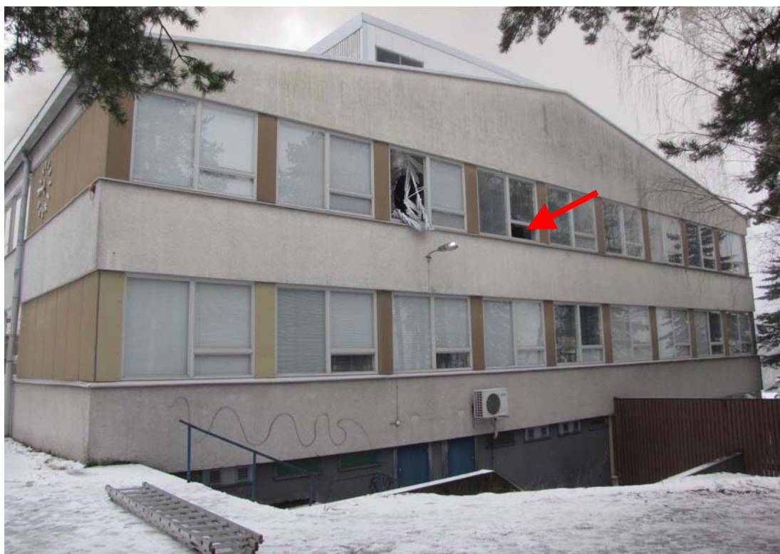
Kuva 7. Kuva koulurakennuksen itäpäädyestä. Opinto-ohjaaja ja opiskelija pelastettiin kuvassa näkyvillä sarjatikkailla ikkunan kautta (punainen nuoli). (Kuva: poliisi)
