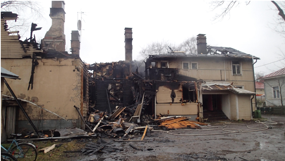
Kuva 1. Puutalon länsipuoli sisäpihan suunnasta paloa seuranneena iltapäivänä (Kuva: OTKES)
