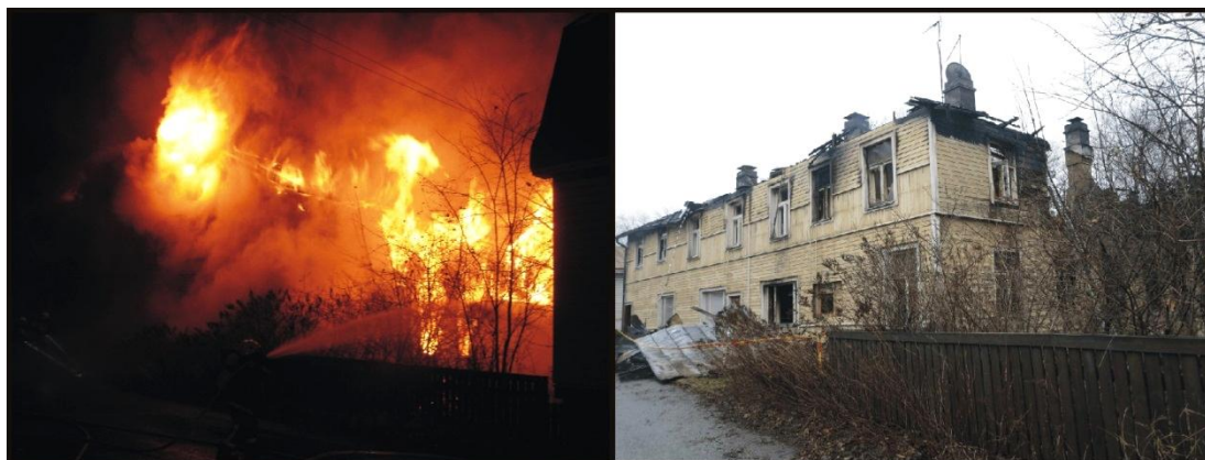
Kuva 7. Talon pohjoispääty paloi voimakkaasti usean huoneiston alueella ja ullakolla pelastuslaitoksen ensimmäisten yksiköiden saapuessa paikalle. Vasen kuva on sammutustöiden alkuvaiheesta ja oikeanpuoleinen kuva samalta paikalta seuraavana aamuna. (Kuvat: Varsinais-Suomen pelastuslaitos)
