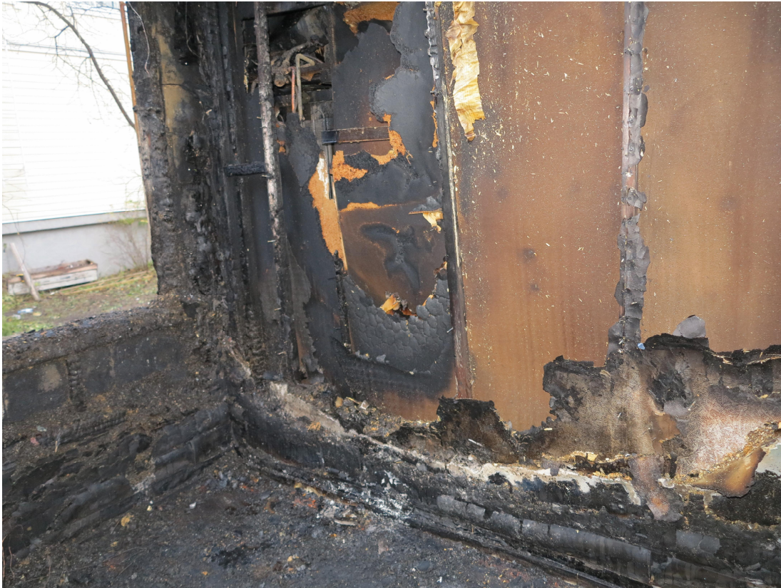
Kuva 10. Asuntojen B ja C välinen puhki palanut seinä. (Kuva: Varsinais-Suomen pelastuslaitos)
