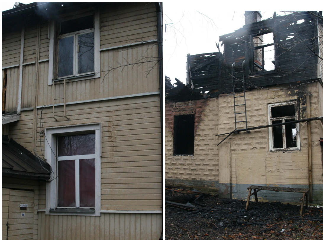
Kuva 9. Eri aikoina asennettuja varatietikkaita (Kuvat: OTKES)
