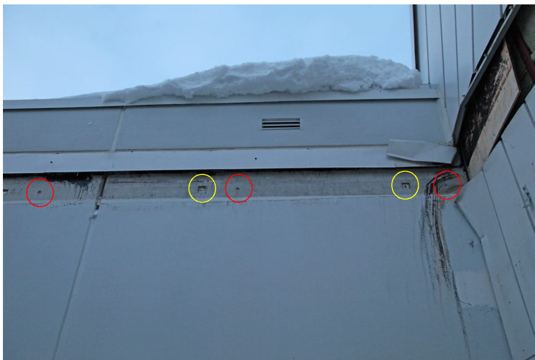
Kuva 3. Puurakenteinen katos oli kiinnitetty kiila-ankkureilla betoniseinään punaisilla ympyröillä merkityistä kohdista. Katos romahti, kun kiila-ankkurit katkesivat. Suunnitellut kiinnityskohdat on merkitty keltaisilla ympyröillä.
