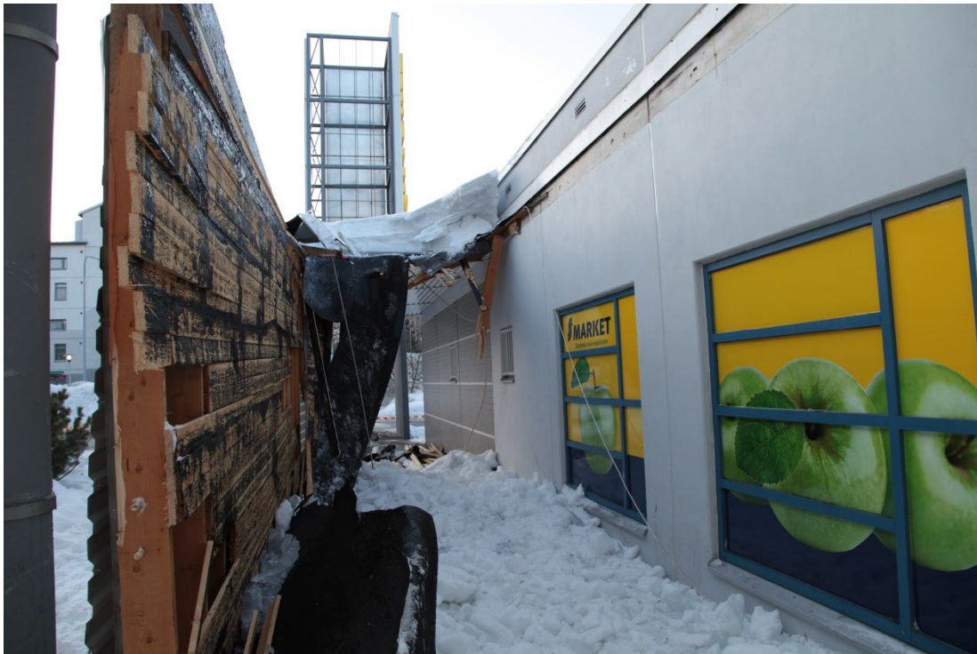
Kuva 2. Katoksen ylös jäänyt osa. Katoksen ja rakennuksen seinän liittymäkohdassa oli 90 cm korkeusero. Lunta oli kinostunut ja pakkautunut tähän kohtaan merkittävä määrä. Kuvassa vasemmassa reunassa on romahtanut katos, joka jäi osittain pystyyn. Kattohuopa on revennyt irti. (kuva: poliisi)
