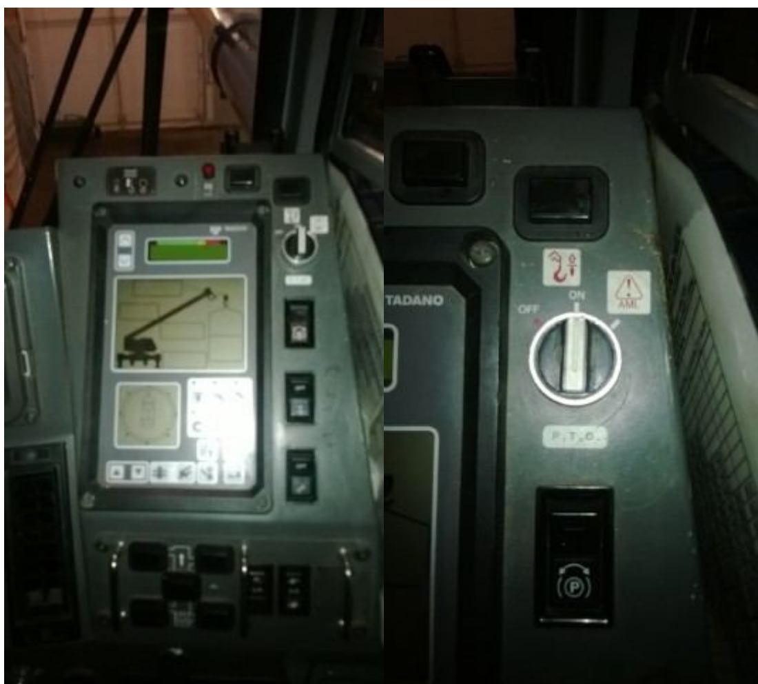
Kuva 6. Vasemmassa kuvassa kaatuneen nosturin valvontalaite, jonka oikealla puolen ylhäällä on turvalaitteen ohituskytkin. Ohituskytkin lähikuvassa oikealla.
