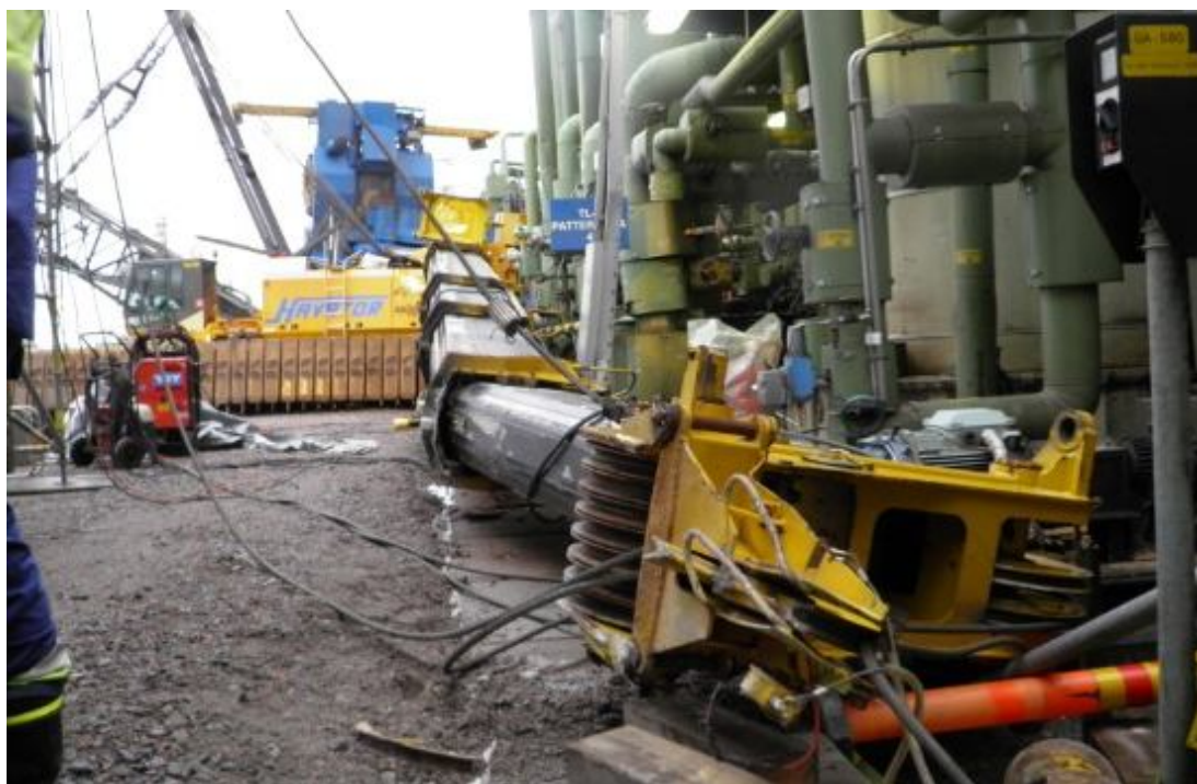
Kuva 3. Autonosturi (sininen) kaatui päin koottavaa telanosturia (keltainen). Etualalla näkyvä autonosturin puomi kaatui aivan prosessiputkistojen viereen. Puomin pituus kaatumishetkellä oli vajaat 28 metriä. Kuvassa näkyy myös tela, jota onnettomuuden tapahtuessa oltiin nostamassa. (Kuva: Itä-Uudenmaan pelastuslaitos)
