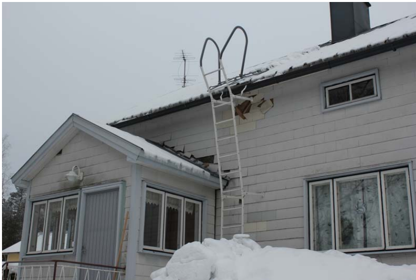
Kuisti irti; Veranda som slitits loss; A porch detached from the house
