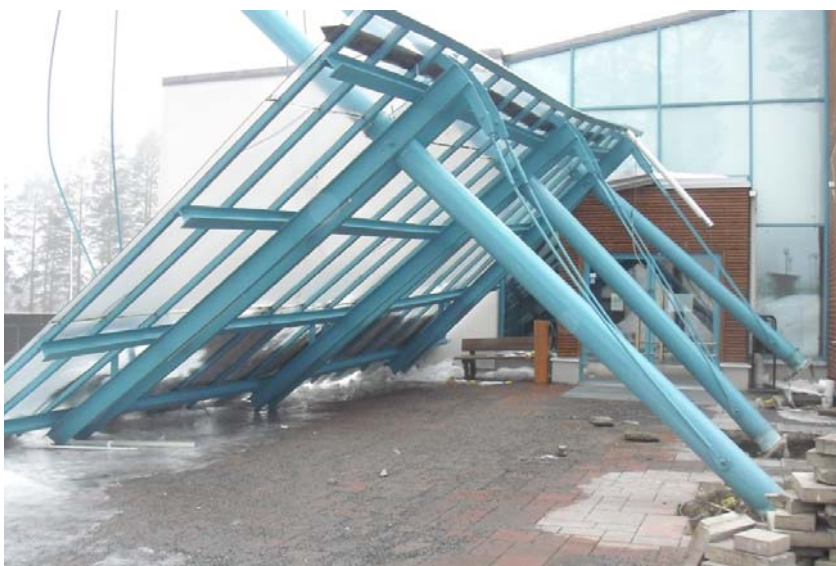
Teräsrakenteinen katos; Skyddstak med stålkonstruktion; Steel-frame shelter (Kuva: Risto Tonteri)
