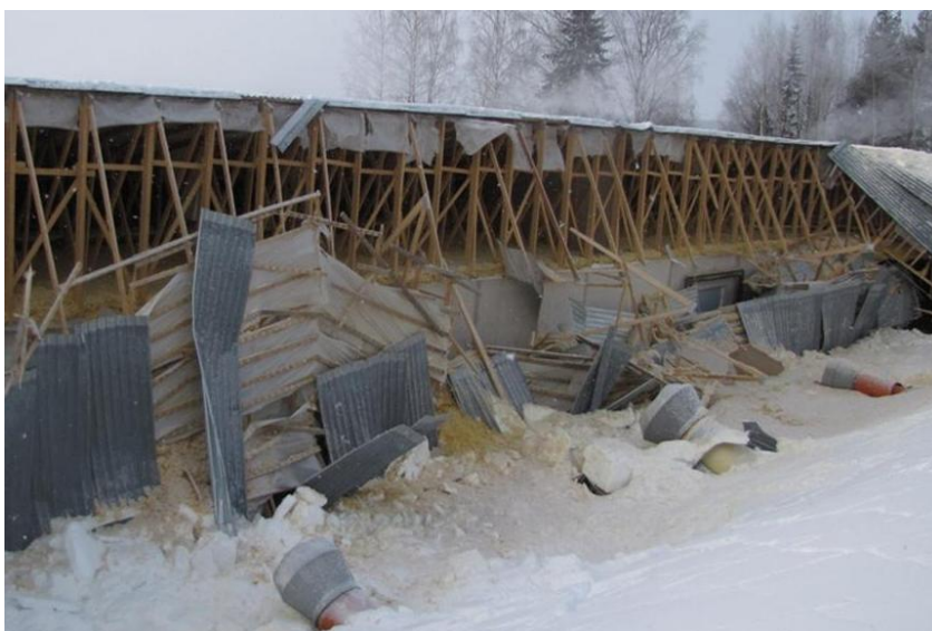
Eläinsuoja, naulalevyristikot; Djurskydd, spikplåtsfackverk; Animal shelter, lattices made from nail plates (Kuva: Etelä-Pohjanmaan pelastuslaitos)
