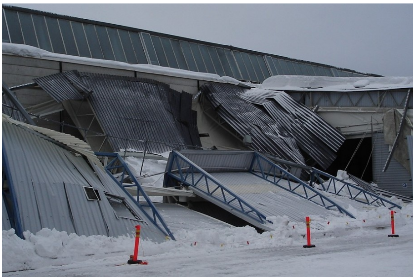
Teräskehä; Stålram ; Steel frame (Kuva: Länsi-Uudenmaan pelastuslaitos)
