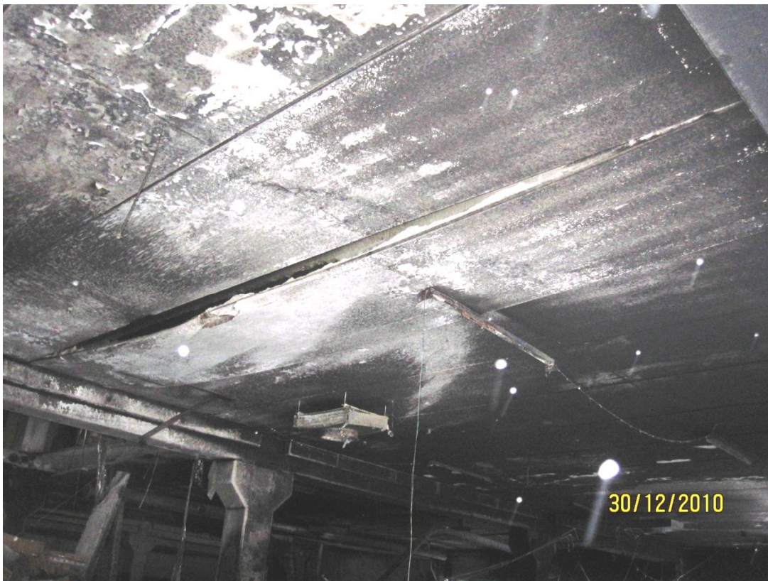
Kuva 19. Laatan ylä- ja alapinta ovat haljenneet kannaksien kohdalta erilleen. (Kuva: Otkes)
