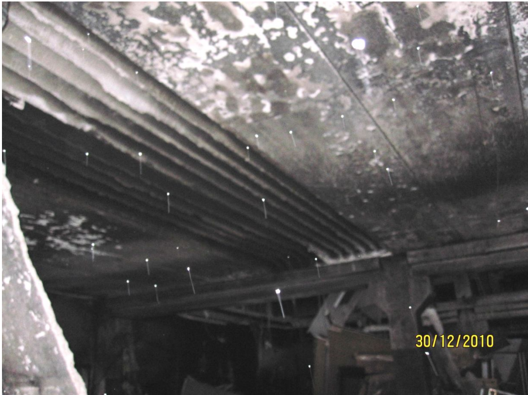
Kuva 20. Ontelolaatan alapinta on irronnut toiselta tuelta ja romahtanut tilaan. (Kuva: Otkes)
