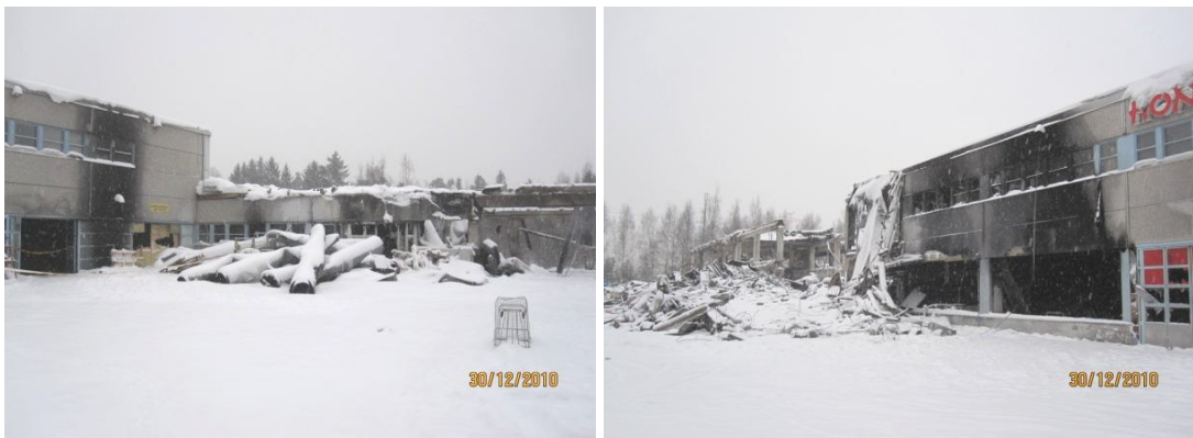
Kuvat 11 ja 12. Tuhoutunut rakennus kuvattuna 30.12.2010 yläpuolelta (vas) ja alapuolelta (oik) suunnista. (Kuva: Otkes)
