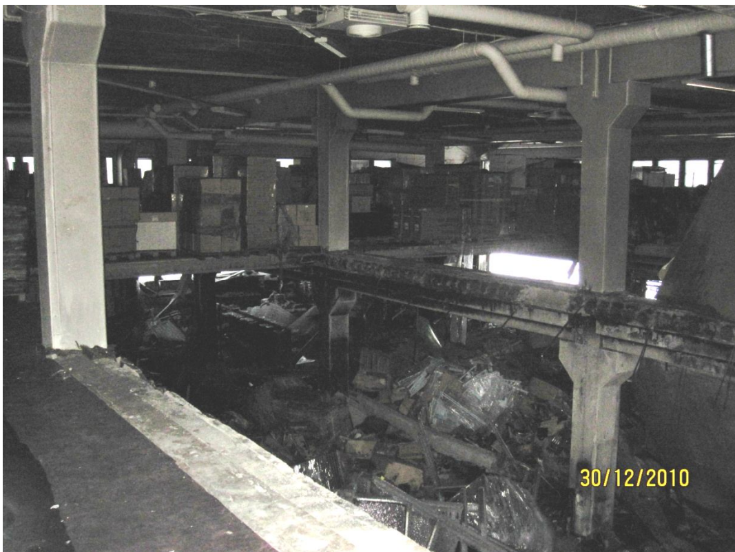
Kuva 21. Ontelolaattojen ja pintavalun sortuessa tilaan, jäivät pilarit ja palkit ehjiksi. (Kuva: Otkes)
