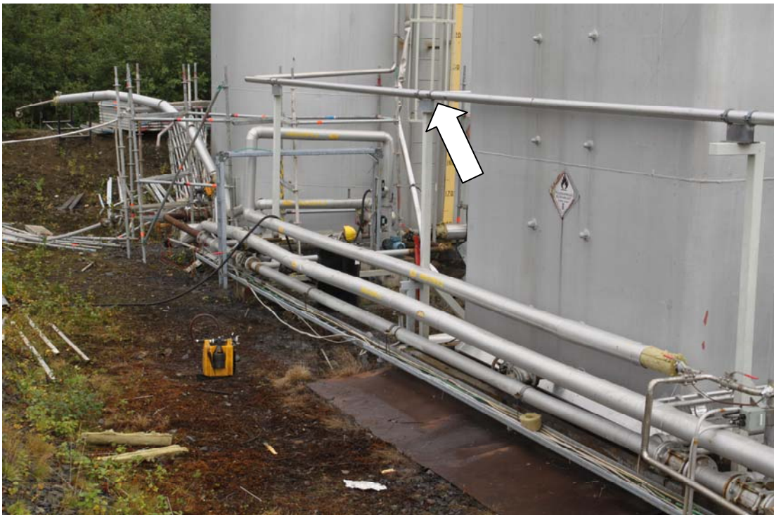
Kuva 2. Säiliöiden yhteinen hönkälinja. Kuvassa etualalla on työn ajan käytössä ollut säiliö. Hönkälinja käytössä olleelle säiliölle lähtee nuolen osoittamasta kohdasta. (Kuva: Poliisi)
