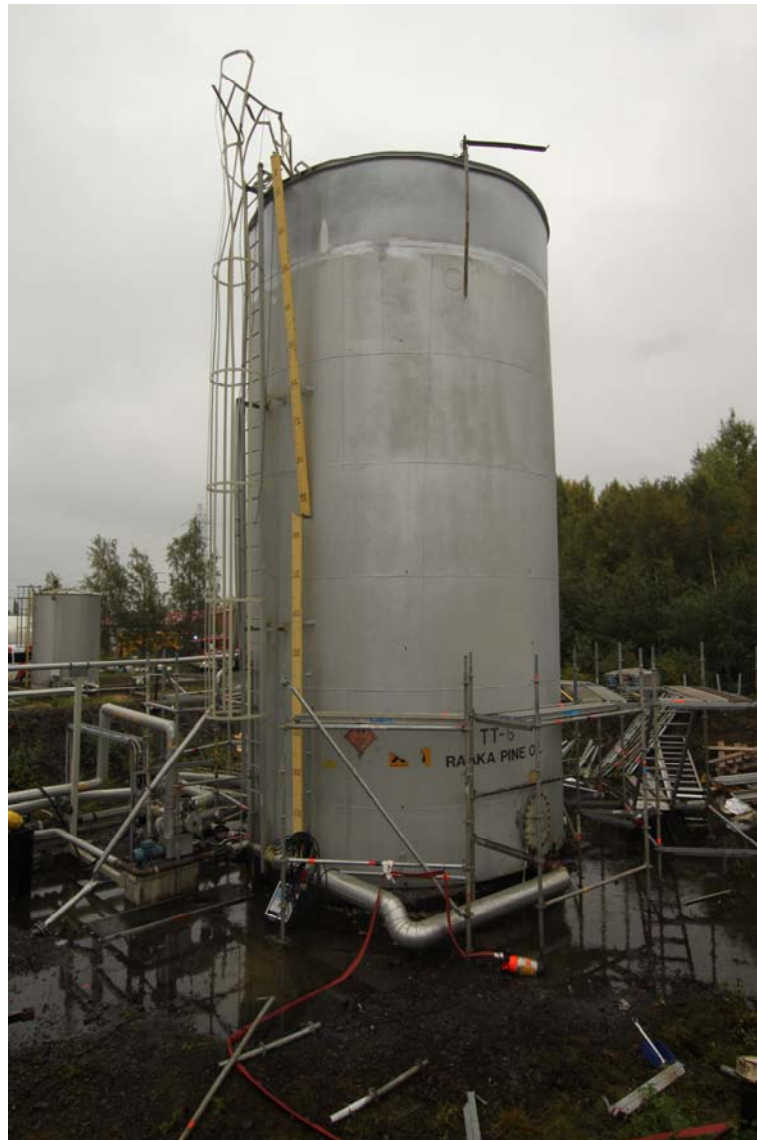
Kuva 1. Tuhoutunut säiliö, jonka yläosa on lentänyt pois räjähdysen voimasta. (Kuva: Poliisi)
