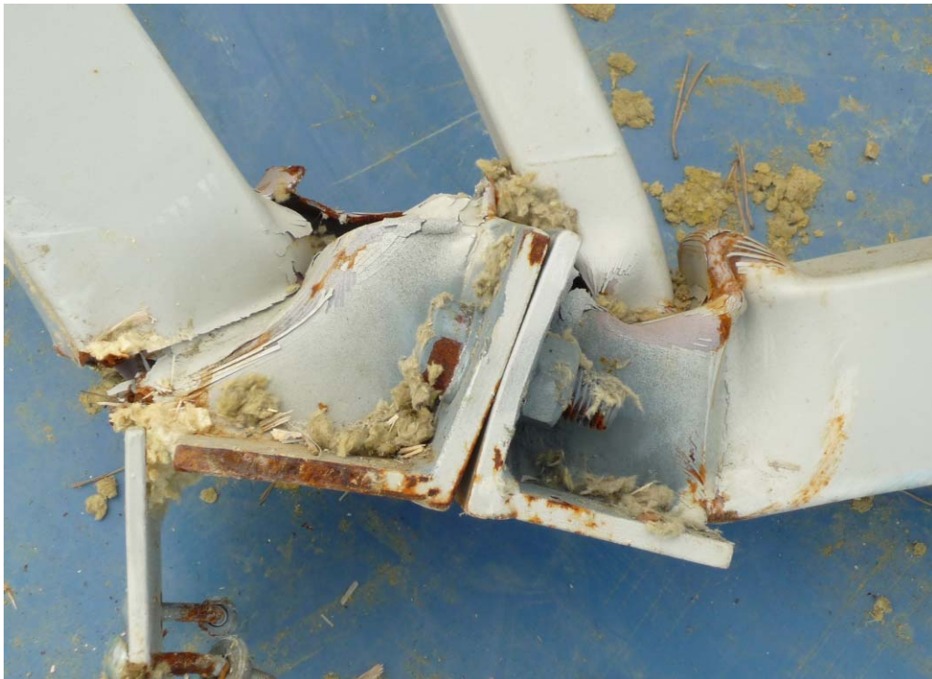
Kuva 15. Katon sortumisesta aiheutuneita vaurioita alapaarten liitoksessa.
