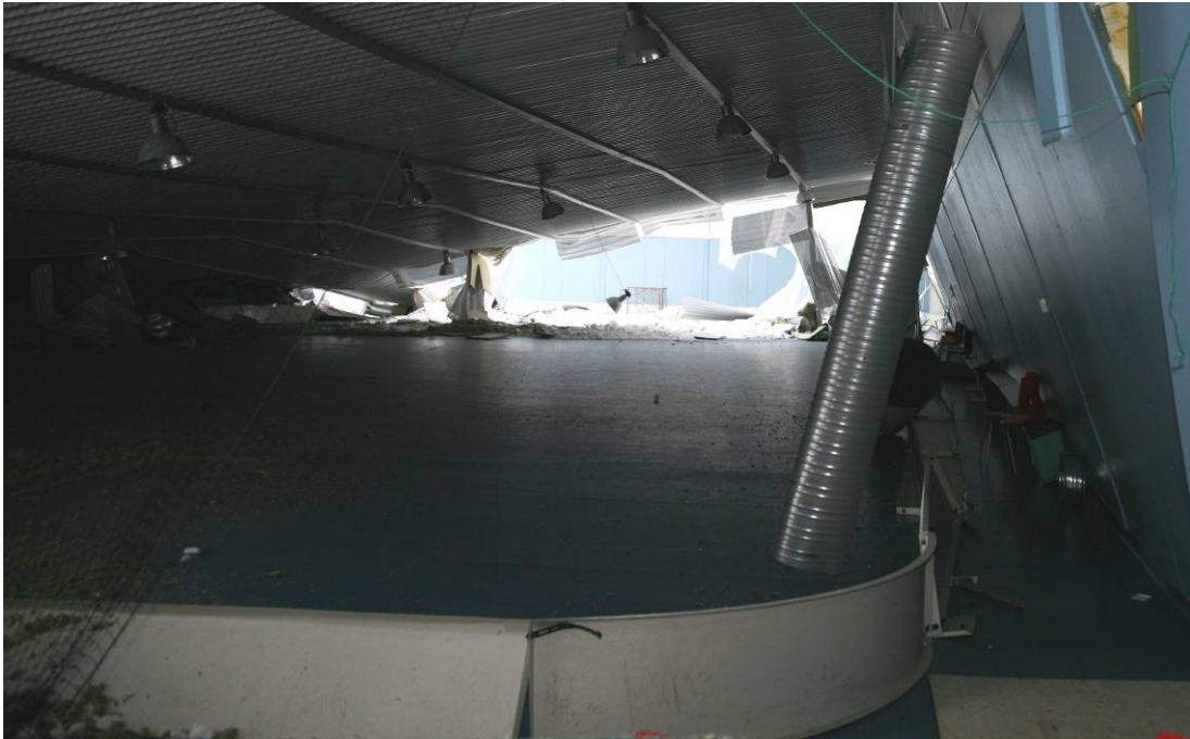
Kuva 4. Hallin katto painui lattiaan asti hallin keskilinjalla (kuvassa vasemmalla), mutta seinän viereen jäi tilaa. Kuva on kadun puoleisesta osasta. (Kuva: poliisi.)
