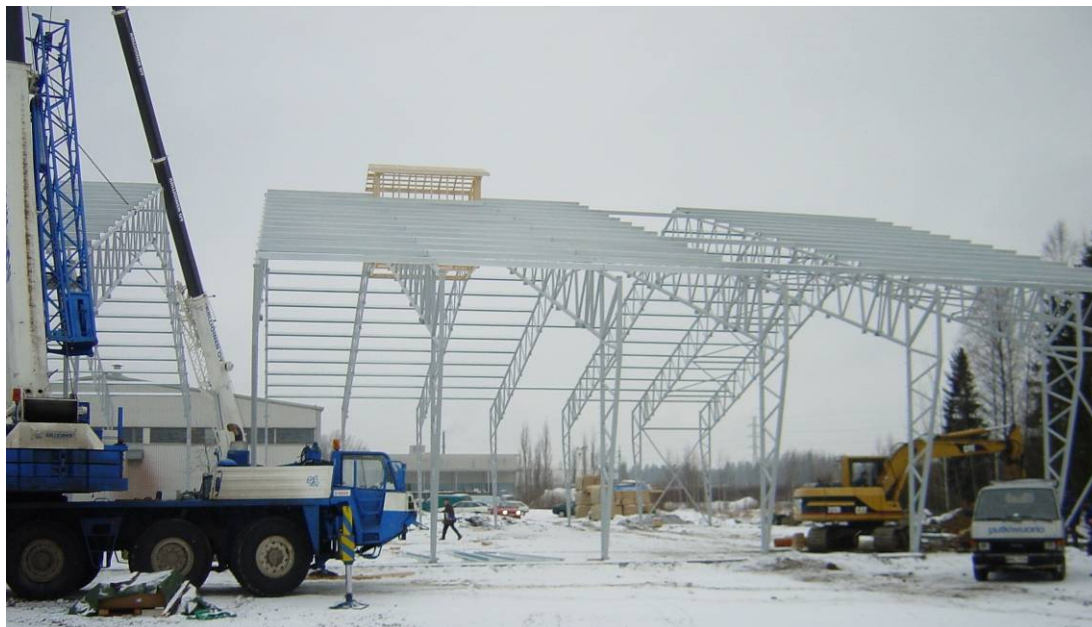
Kuva 8. Vastaavanlaisen hallin asennustapa.
