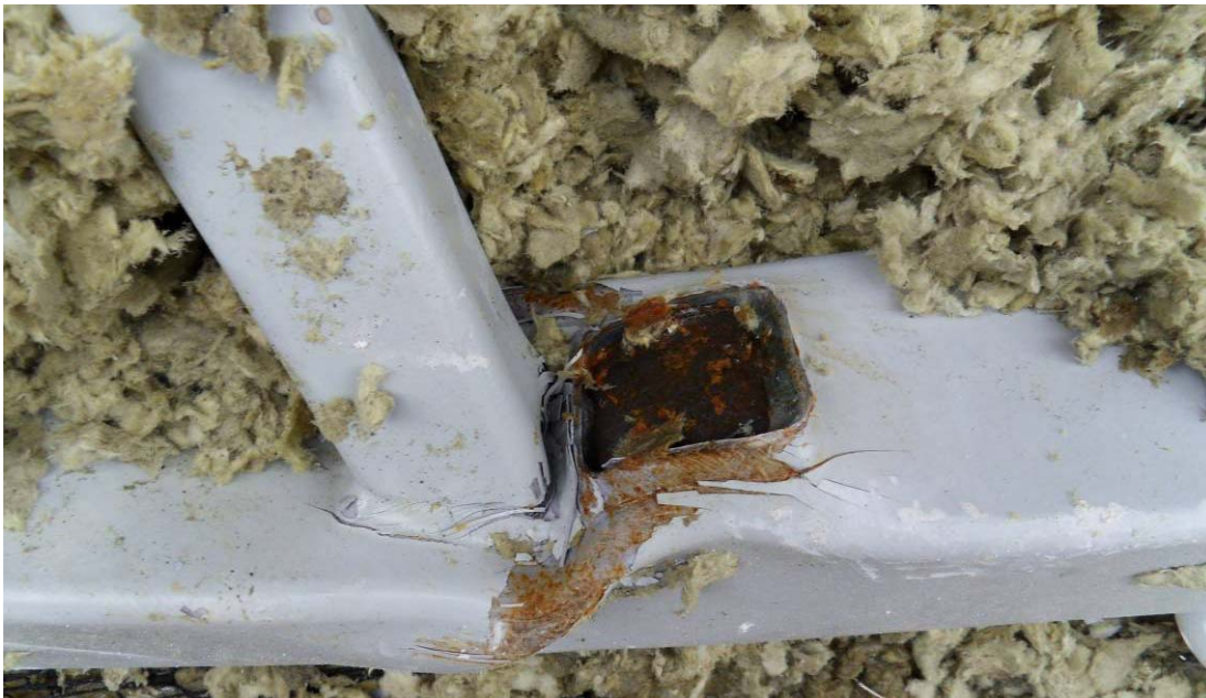
Kuva 11. Paarteista repeytyi irti diagonaaleja siten, että pala paartetta (tumma reikä) leikkautui irti ja jäi kiinni diagonaalien päähän. (Ari Rinne © 2010)
