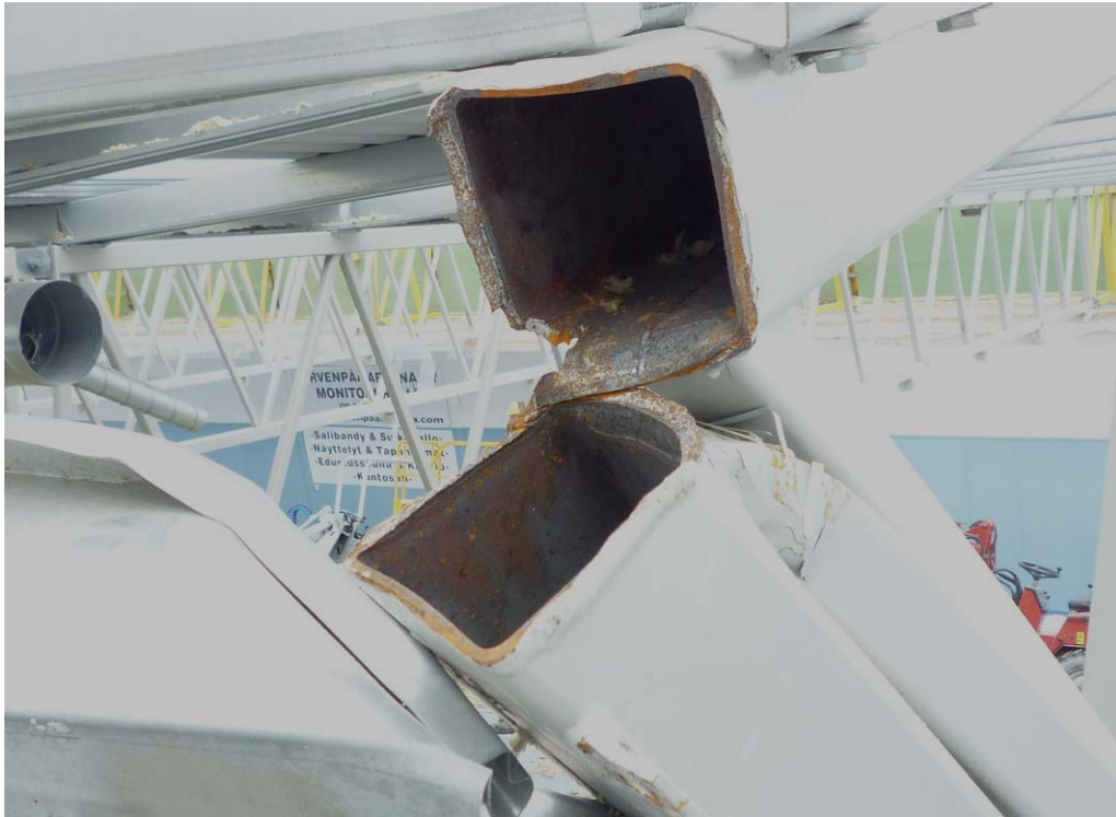
Kuva 14. Vaurioitunut jatkoshitsausliitos pääkannattajan yläpaarteessa harjan kohdalla.
