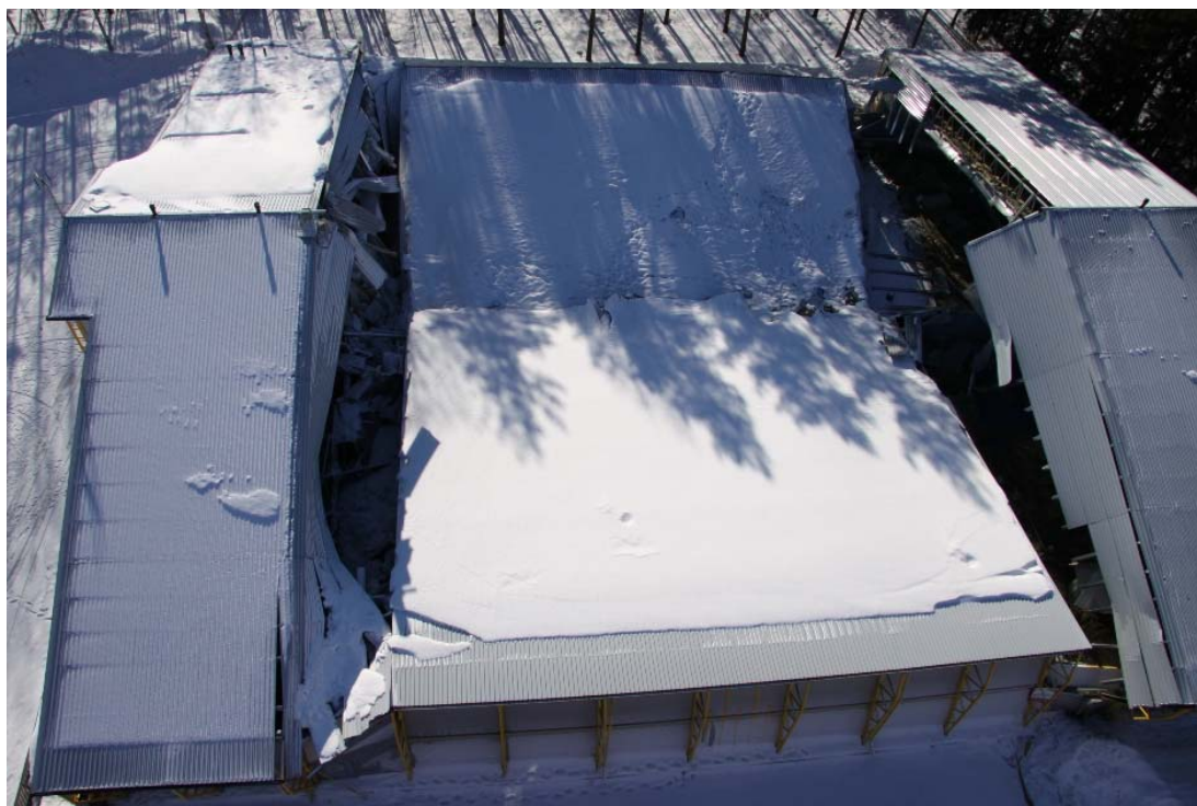
Kuva 9. Halli ylhäältä päin kuvattuna. (Kuva: pelastuslaitos 12.3.2010.)
