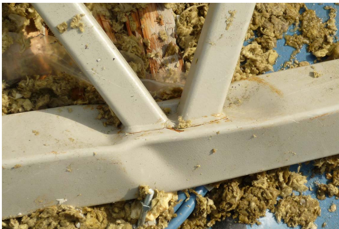
Kuva 13. Parreputken vaurioitunut diagonaaliliitos myötökuvioineen. Parreputki on olennavasti taittunut vasta katon sortuessa.
