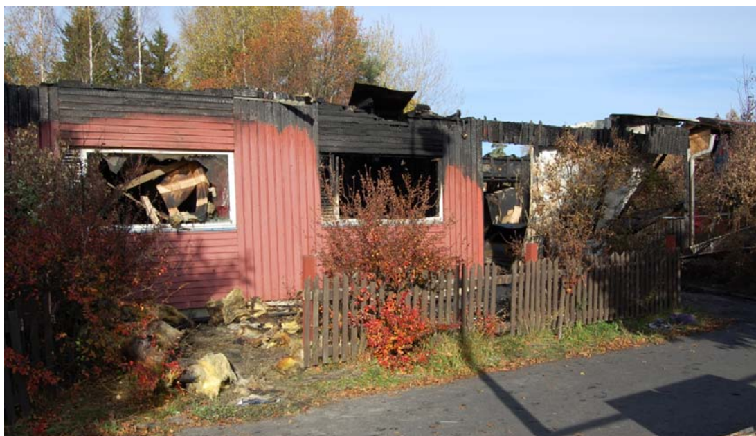
Kuva 1. Tuhoutunut rakennus Naantalissa tulipaloa seuraavana päivänä. (Kuva: OTKES)
