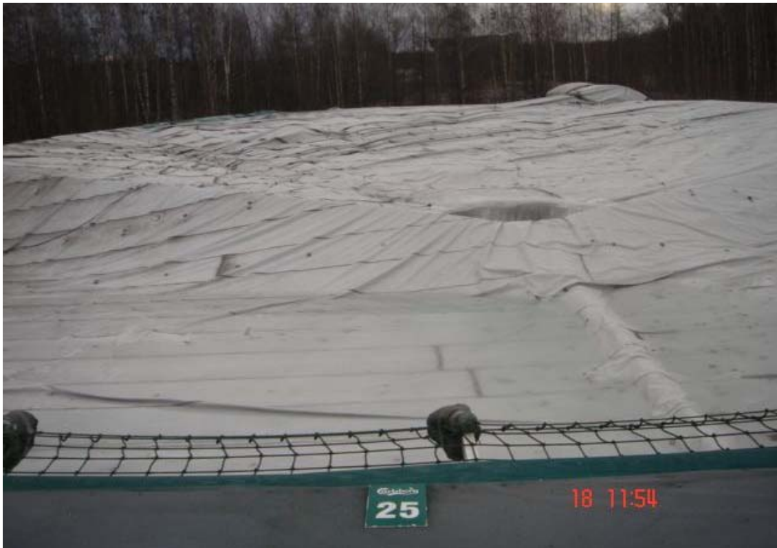
Kuva 3. Kuva on otettu sortuneen ylipainehallin toisen kerroksen lyöntipaikalta, jota vastapäätä on hallin varauloskäytävä. Varauloskäytävän yksi maahan asennetuista ankkureista oli noussut maasta ylös. Repeämien kohdalta hallin ylipaine purkautui äkillisesti ja halli painui kokonaan kasaan.
