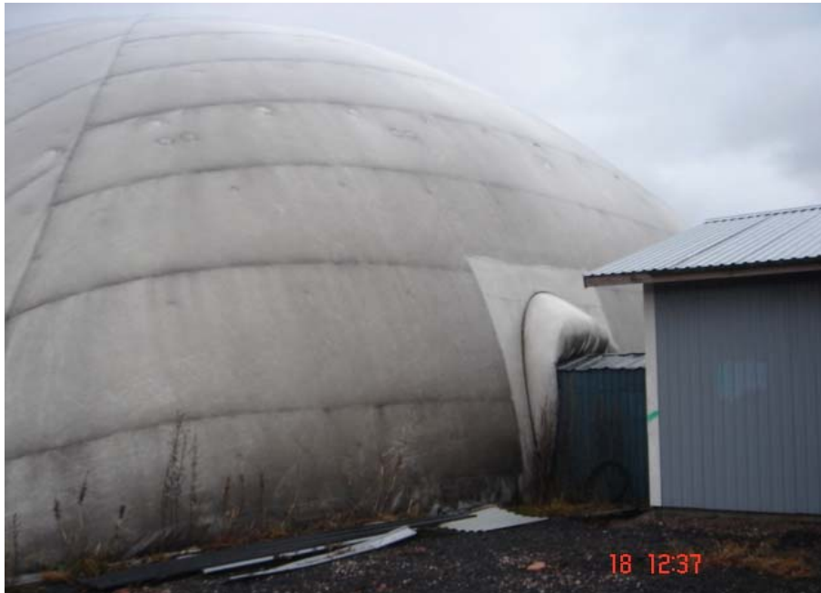
Kuva 1 Sortunut ylipainehallia vastaava toinen ylipainehalli. Kuvassa näkyy hallin sisäänmenokäytävä, jossa on pyörivä ovi, jotta paine ei pääse purkautumaan ovesta kuljettaessa.
