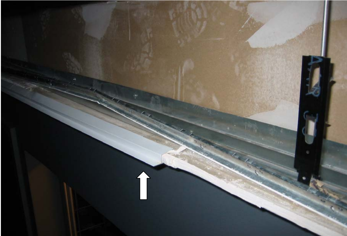
Kuva 4. Keittiön seinän puolella oleva kipsilevykaistale ja sen leikattu reuna. Nuolella on merkitty huulloslista sekä päällä taittunut L-lista. Oikealla ripustus, joka kannattaa kaistaleen tukirakennetta.
