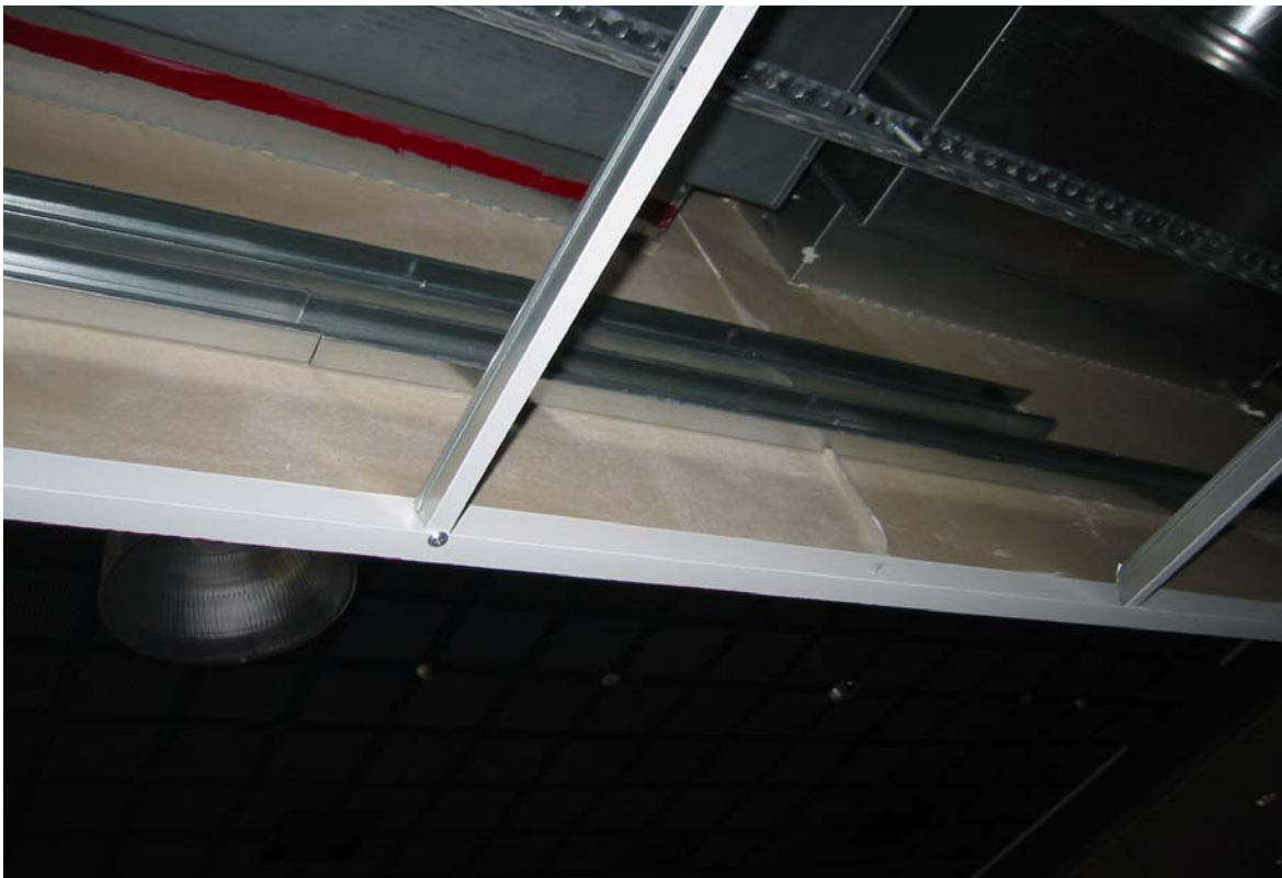
Kuva 5. Atriumin puoleisen seinän pystyotsa, joka liikkui sivusuunnassa ulkoseinän puoleisella puoliskolla. Kannatinjärjestelmän T-profiileista osa oli kiinnittämättä pystyotsan L-listaan.
