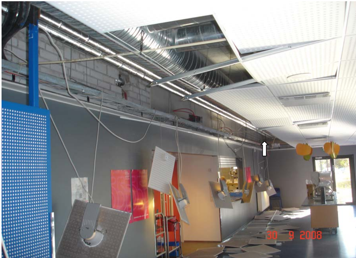
Kuva 2. Pudonnut katon osa, putoaminen alkanut nuolen kohdalta (kuva: Espoon kaupunki)
