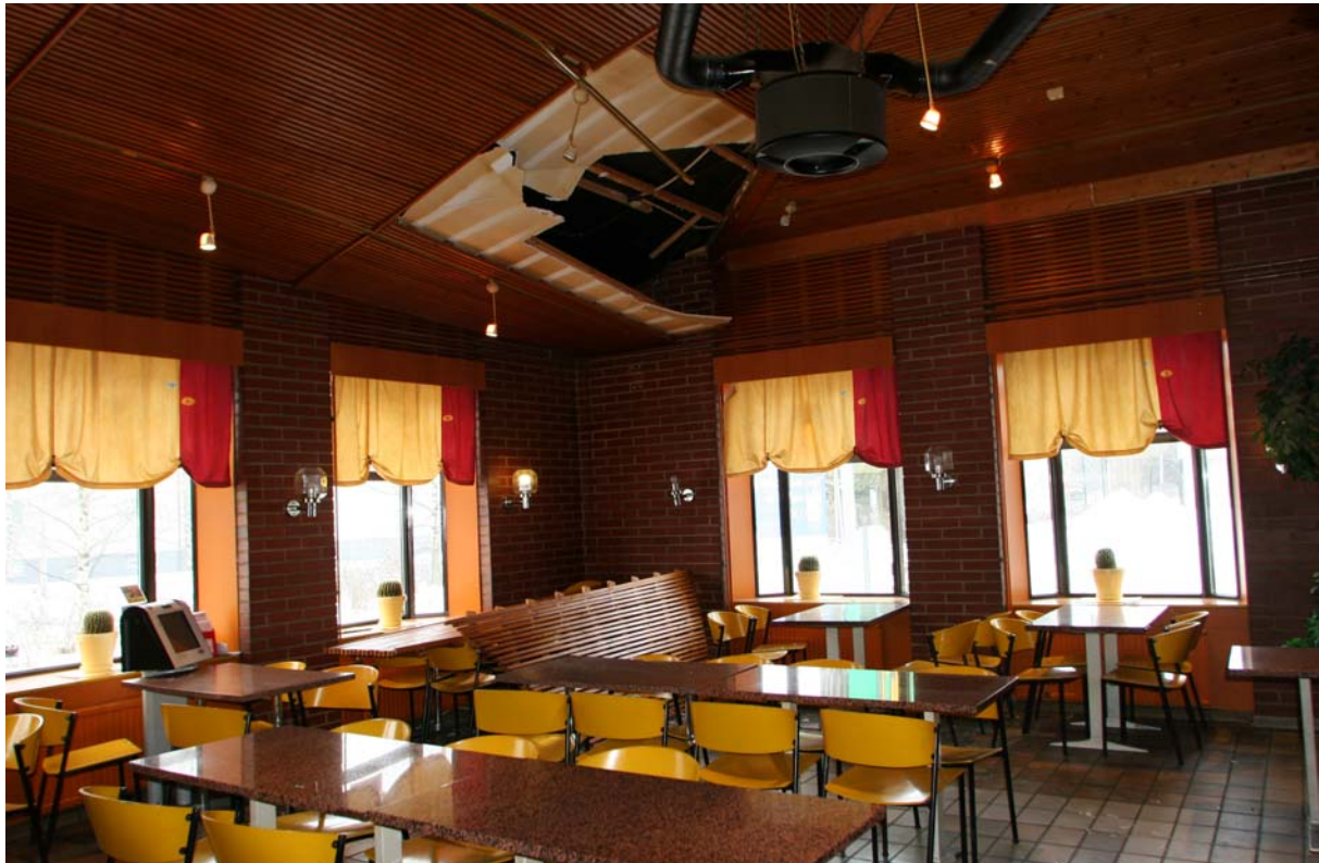
Kuva 1. Sisäkatto putosi alas kahvion ulkoseinän läheisyydestä.
