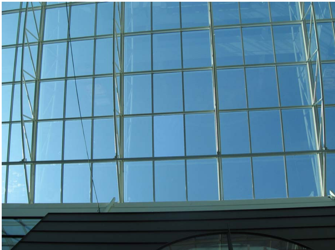
Kuva 3. Vauriokohta suoraan alhaaltapäin kuvattuna. Rikkoutunut lasielementti, josta puuttuu sisin lasi, erottuu lähes kuvan keskellä muita vaaleampana ruutuna. Vaurion yhteydessä ruudun reunoille jäi jonkin verran lasia, mutta se on poistettu jo ennen kuvan ottamista.
