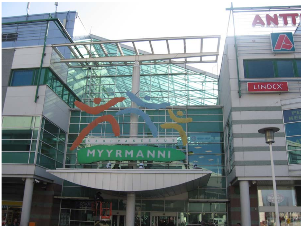
Kuva 1. Pääsisäänkäynti kauppakeskuksen ulkopuolelta kuvattuna. Pääkäytävän lasinen pulpettikatto näkyy kuvan yläosassa.
