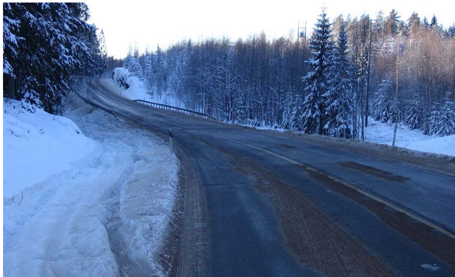
Kuva 1. Onnettomuuspaikka Taavetin suunnasta katsottuna. Haminan suunnasta tultaessa näkyvyyttä häiritsee takana näkyvä harjanne, sen kohdalla oleva kallioleikkaus ja mutka.
