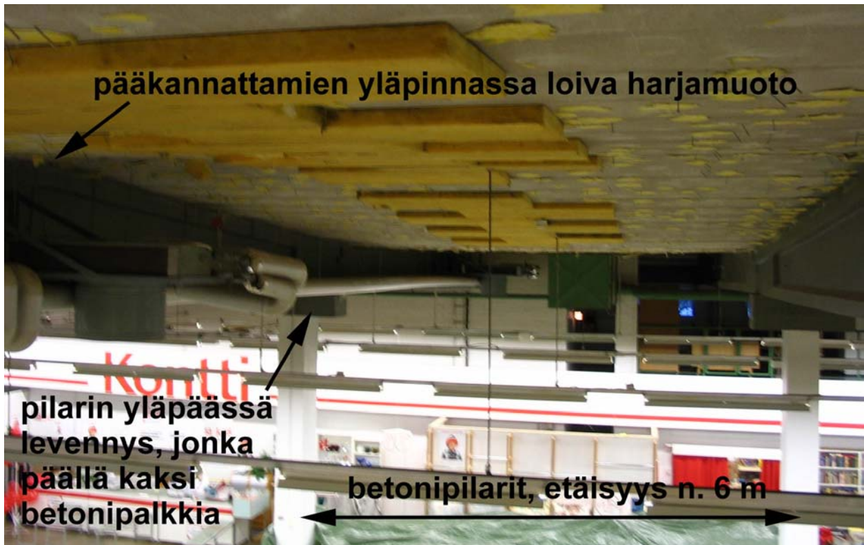
Kuva 3. Betonipilarit ja betoniset pääkannattimet.
