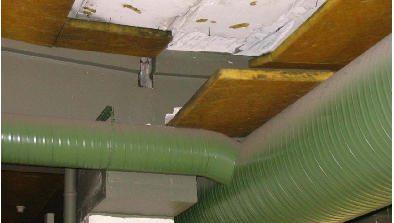
Kuva 5. Perjantaina 17.11. pudonnut eristelevy oli jätetty paikoilleen ilmastointiputken päälle.
