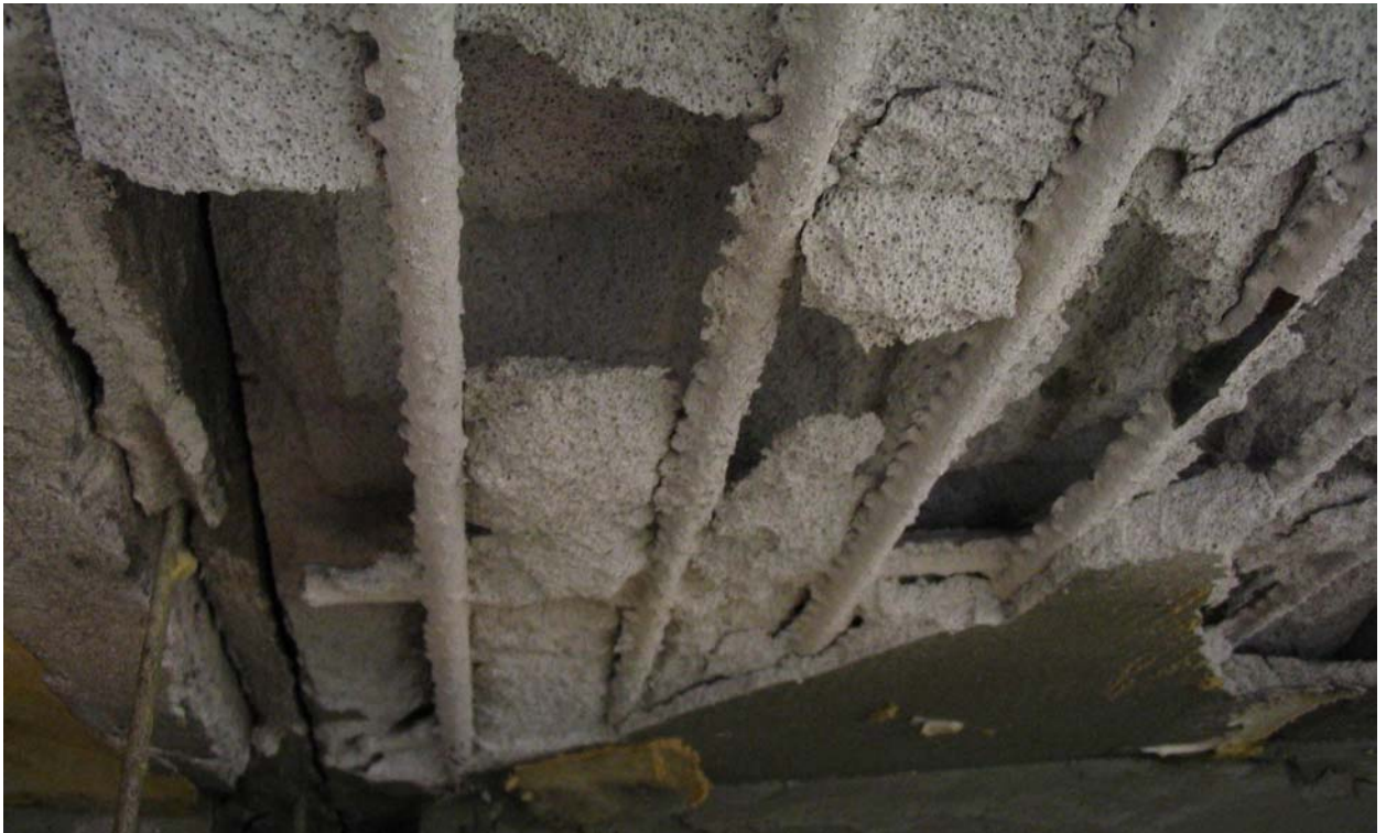
Kuva 6. Pahimman vaurion kohta. Teräkset ovat näkyvissä, mutta ruostetta ei näy.
