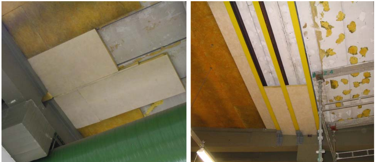
Kuva 4. Katon jiirikohtiin joskus aikoja sitten tehtyjä korjauksia: vasemmalla erivärisiä eristelevyjä ja oikealla kahteen pylväsväliin tehtyjä aika järeitä teräspalkkituentoja. (Teräspalkkien alareuna on maalattu keltaiseksi.)
