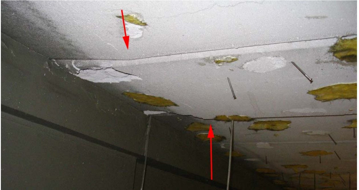
Kuva 7. Jiirien kohdalla olevissa palkeissa näkyy selvästi taitoskohtia lähellä palkin päätä.
