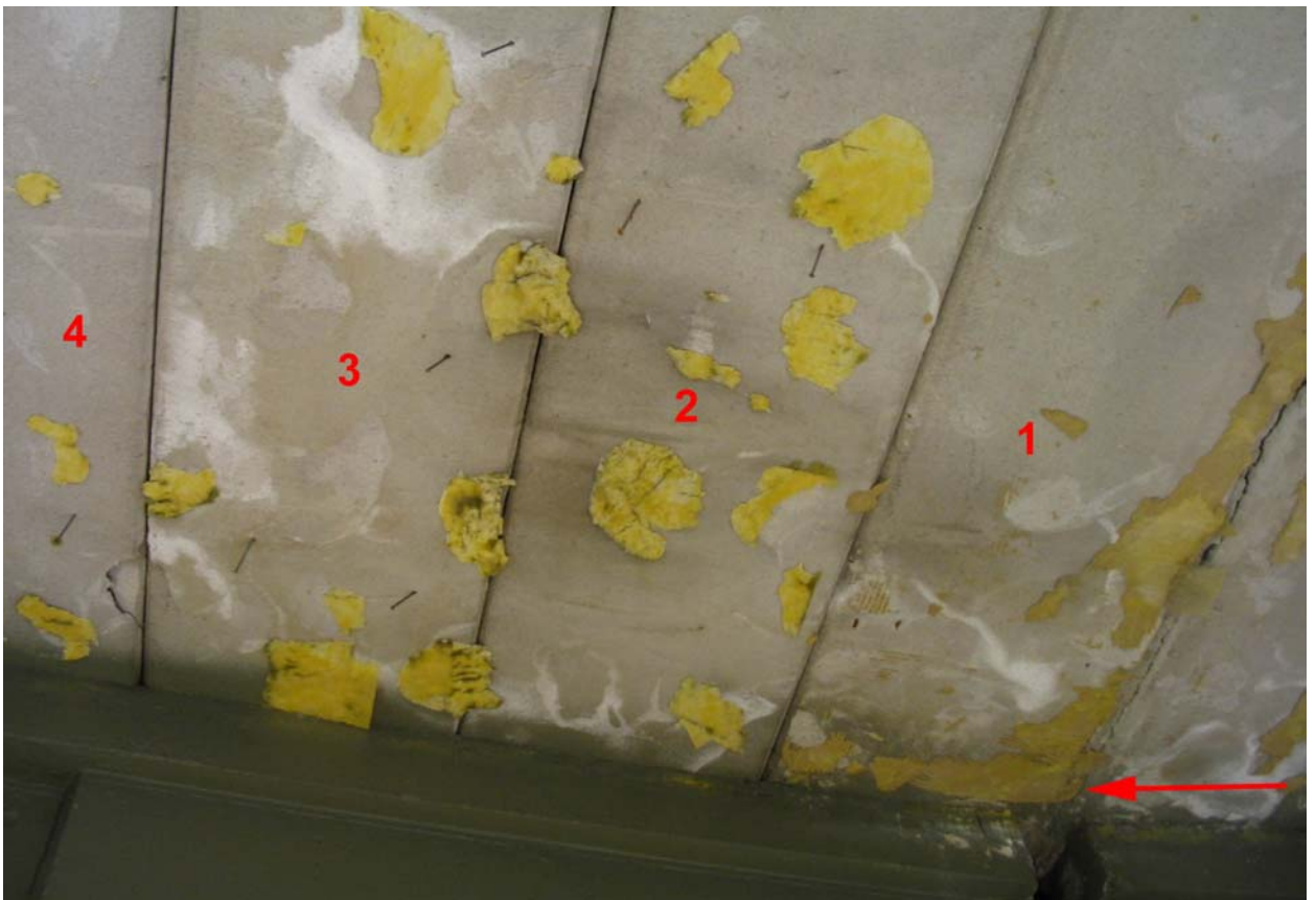
Kuva 8. Kosteusvaurioita (kalkkijälkiä) oli nähtävissä jiirien kohdalla olevissa laatoissa. Jiirin pohjan kohta on merkitty oikeaan reunaan punaisella nuolella. Kolmessa lähimmässä laatussa kalkkijäljet ovat selvät, mutta myös neljännessä laatussa on havaittavissa vaurio.
