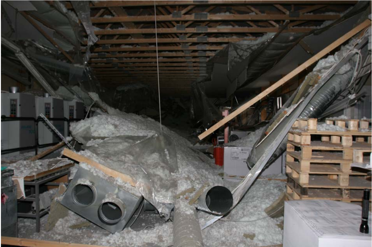
Kuva 1. Painohallin sisäkatto ja siihen ripustetut ilmanvaihto- ja valaisinlaitteet romahtivat alas lattialle.
