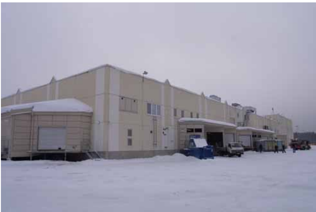
Kuva 3. Kauppakeskus lastauslaitureiden puolelta kuvattuna. (Kuva poliisin tekniikka.)
