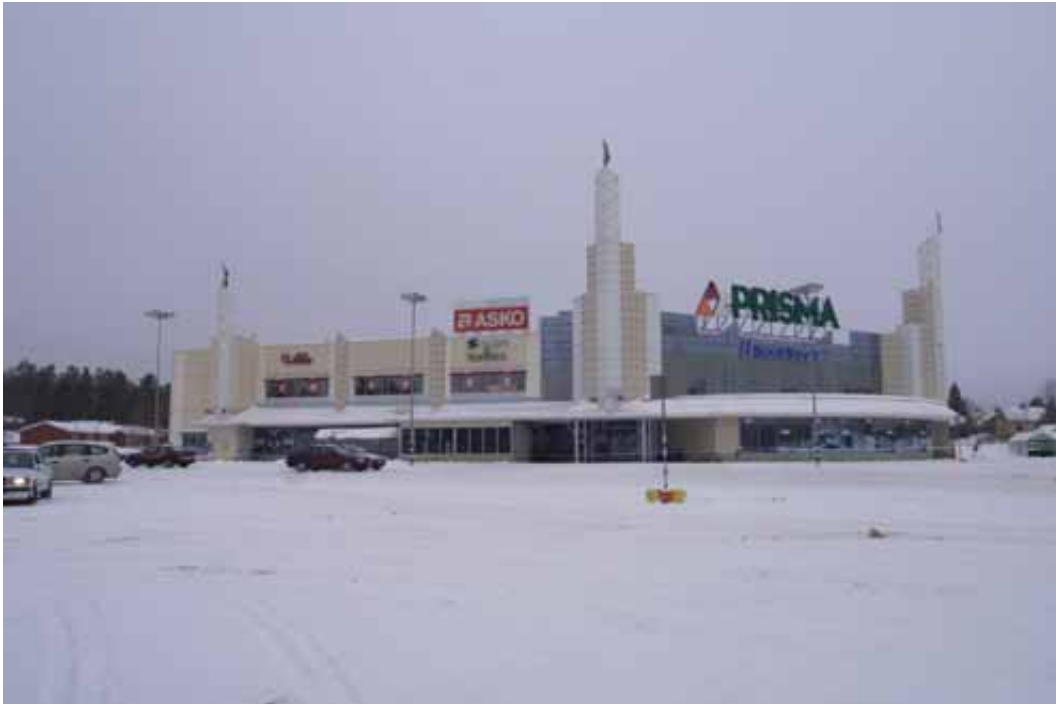
Kuva 2. Kauppakeskus etupihan puolelta kuvattuna. (Kuva poliisin tekniikka.)
