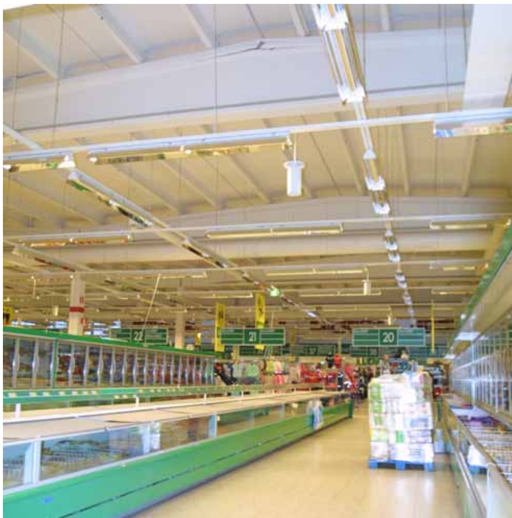
Kuva 4. Murtuma palkissa. Kuvassa näkyy myös autonkuljettajan tuoma tavaralava. (Kuva poliisin tekniikka.)
