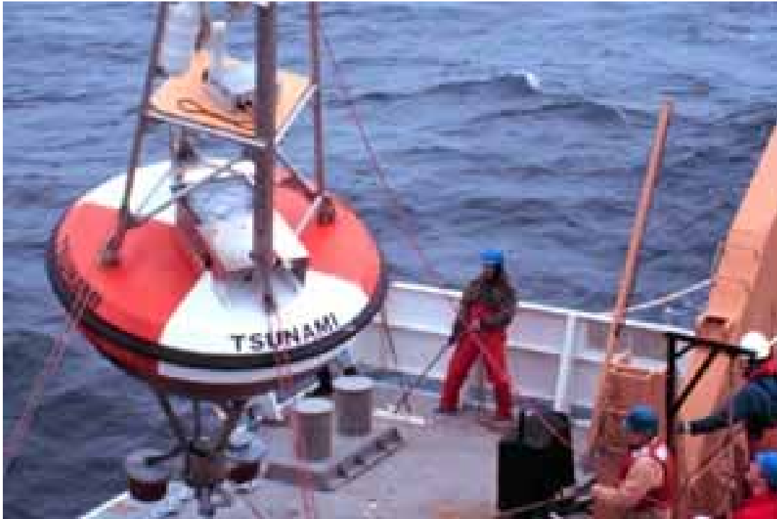
Kuva 5. Tyynenmeren tsunamivaroitusjärjestelmän poijua asennetaan.
