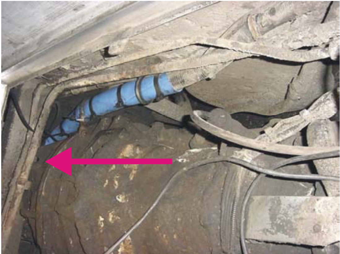
Kuva 22. Korjaamalla tehty akkukaapelin suojaus ja sidonta. Johtosarja on suojattu hankautumiselta suojaputkella ja tuettu hyvin. Punainen nuoli osoittaa moottorin nostokorvaketta, johon kaapeli hankautuu. Kuvattu vaihdelaatikon huoltolukusta. (Kuva Oy Pohjolan Liikenne Ab)
