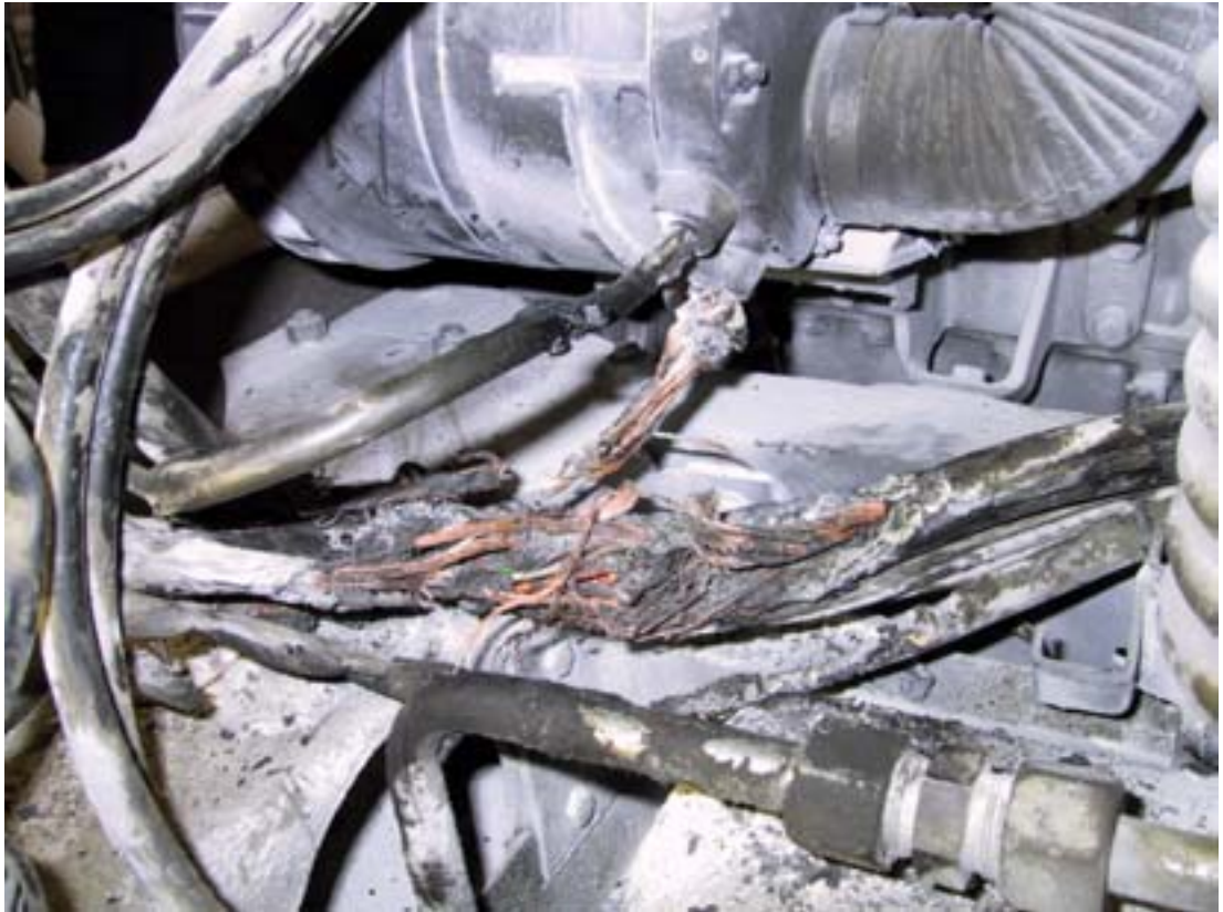
Kuva 11. Palaneita laturin kaapeleita.
