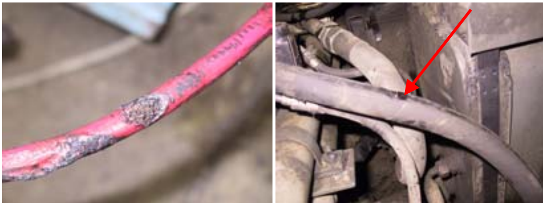
Kuva 7. Latausgeneraattorin virtajohtoon eriste ja teräskudosvahvisteinen hydrauliletkun pintakumi hankautuivat keskenään puhki ja syntyi oikosulku.
