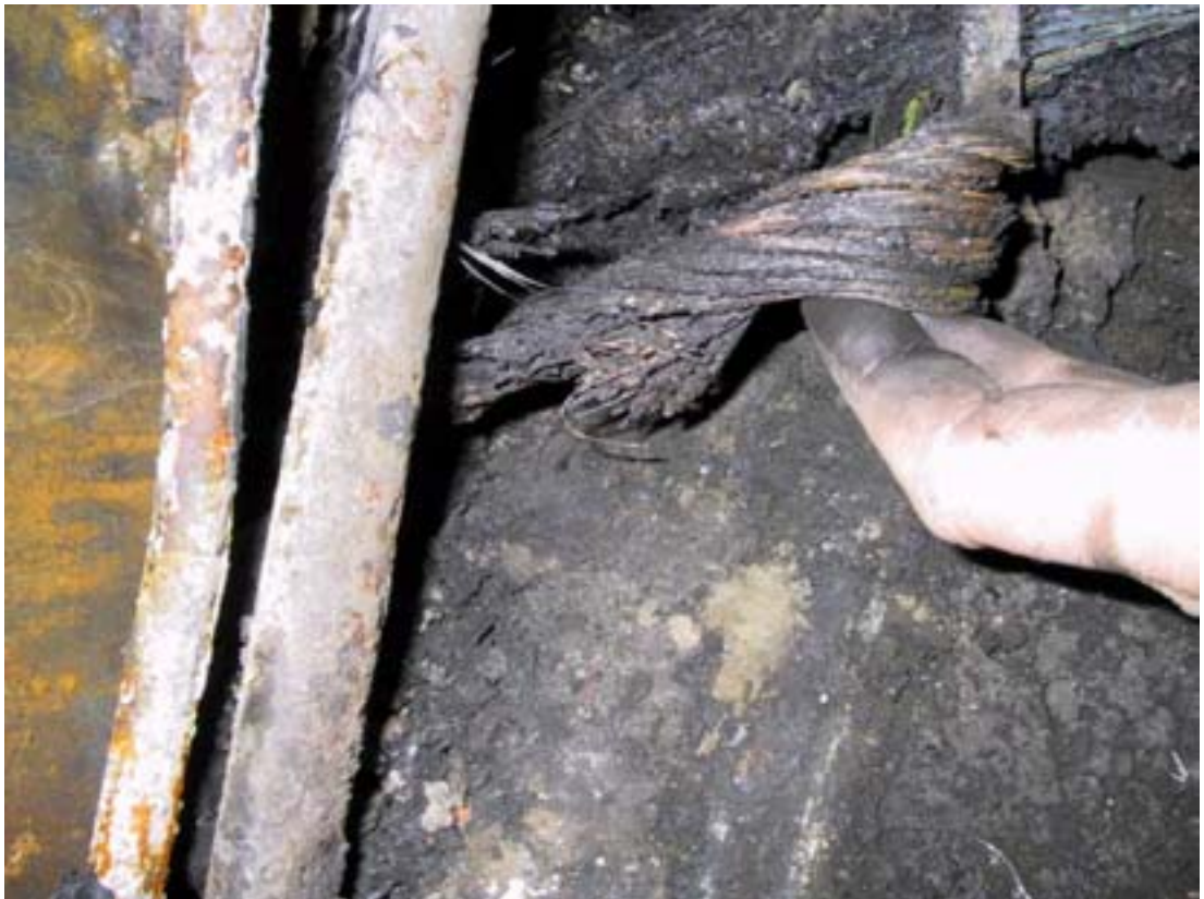
Kuva 13. Poikki palanut akku-kaapeli.
