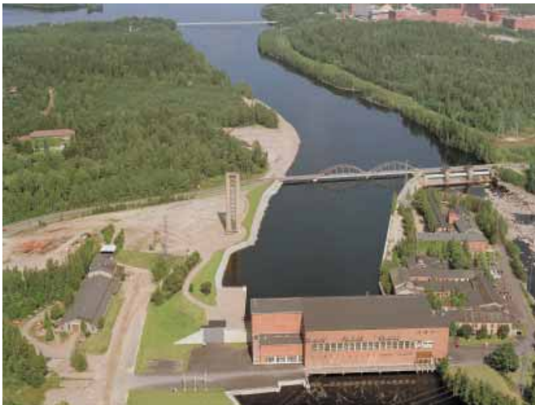
Kuva 1.2 Ilmakuva Tainionkosken voimalasta ja Tornan sillasta.
