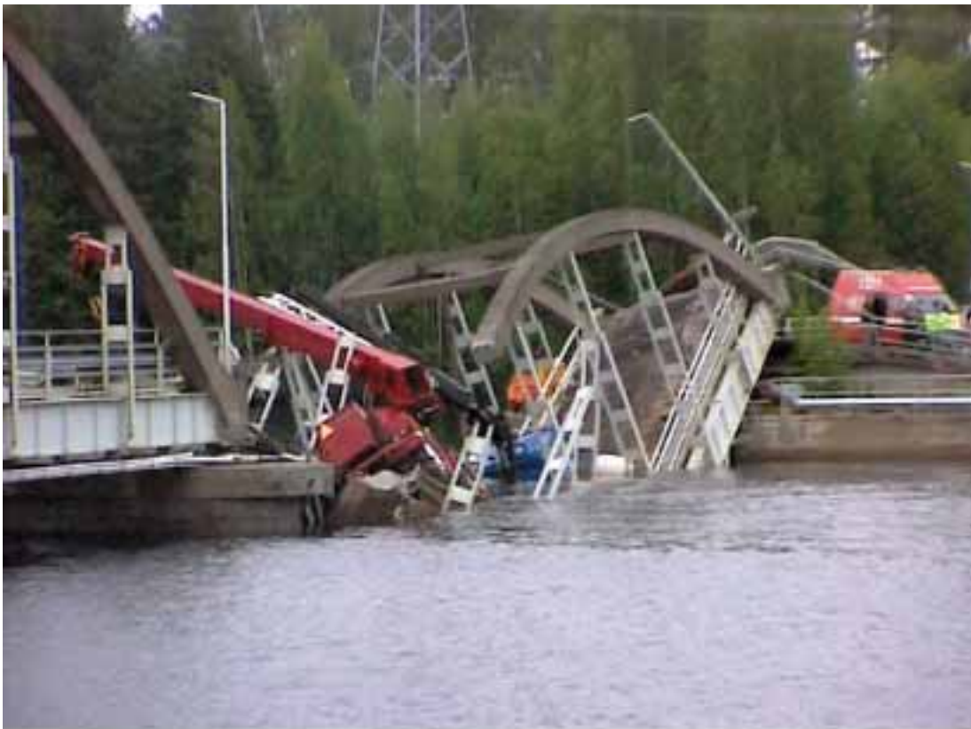
Kuva 1.4 Kuva sillasta (länsiranta, alavirta).
