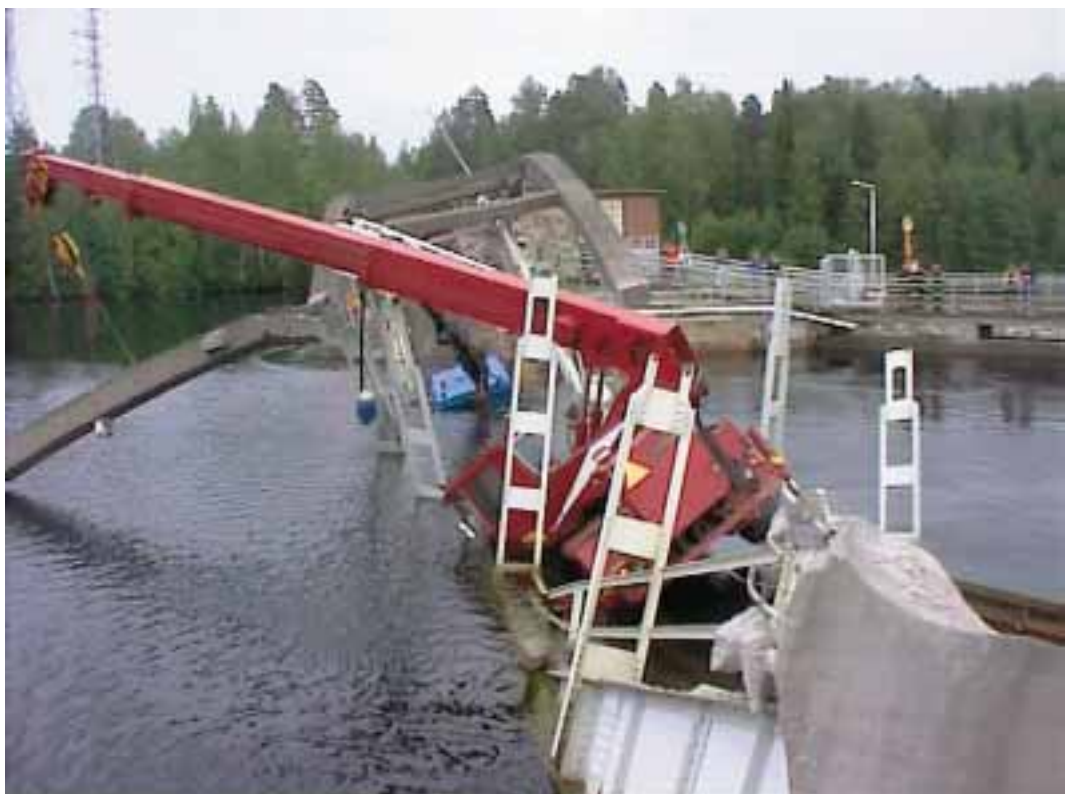
Kuva 1.6 Kuva sillasta sillan pituussuuntaisesti.
