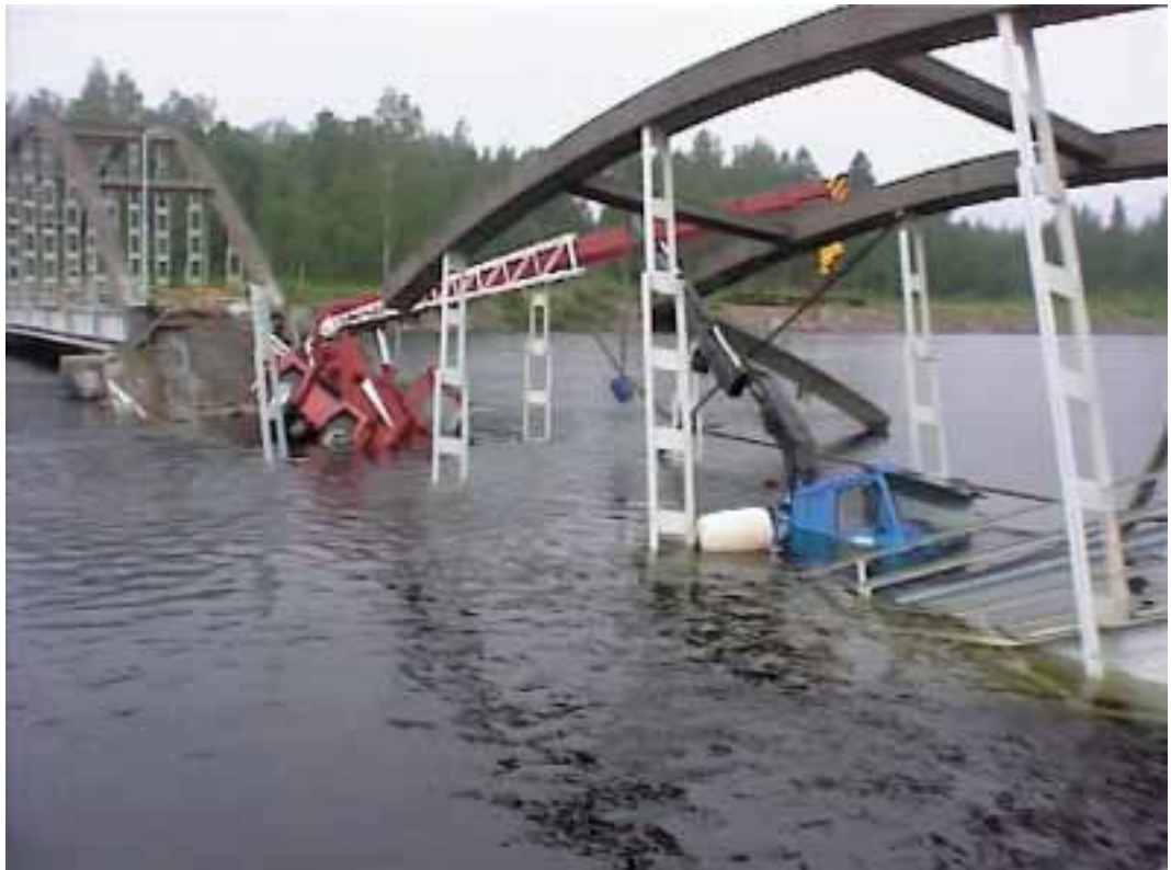
Kuva 1.5 Kuva sillasta (itäranta, alavirta).
