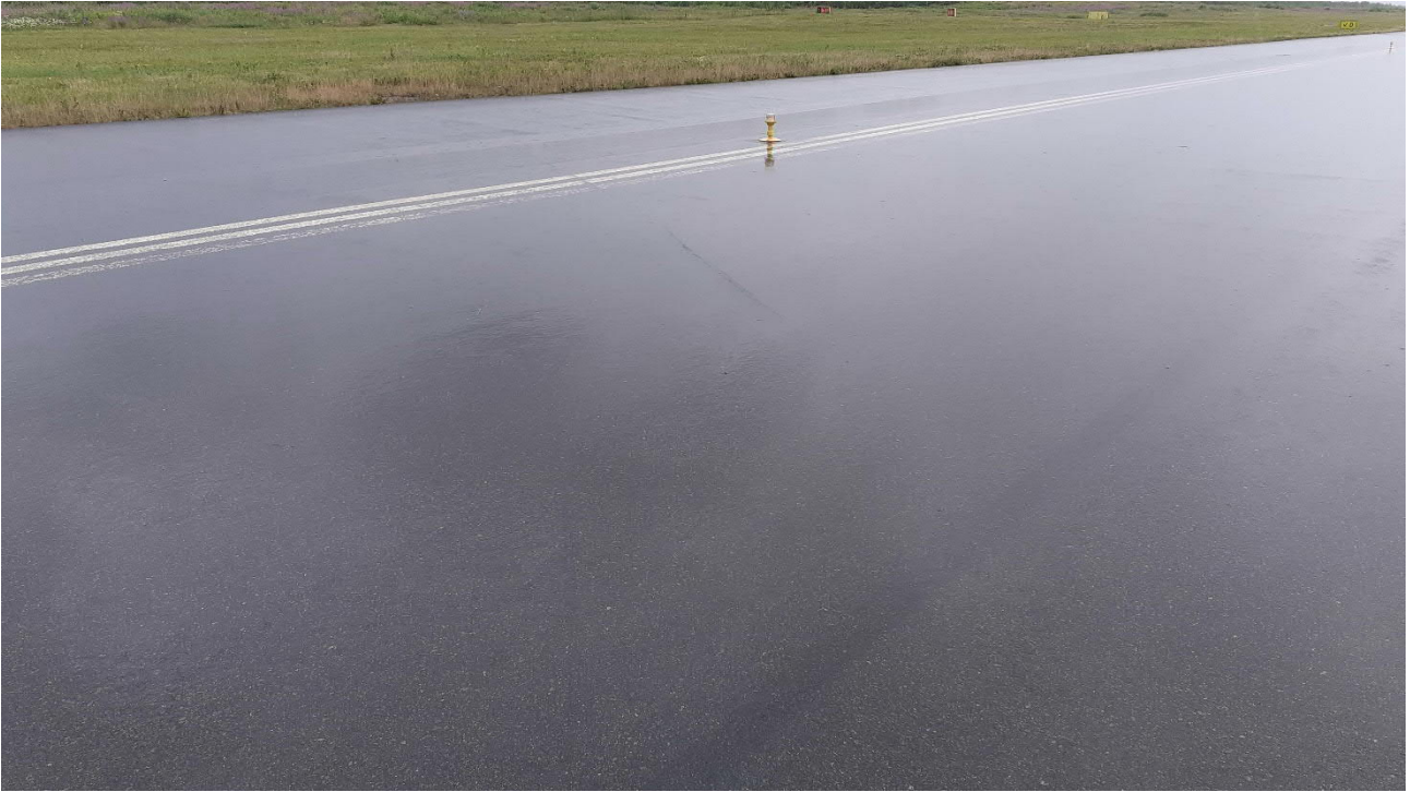
Kuva 1. Päätelineiden pyörien jälkiä kiitotien reunassa. Kuva on otettu onnettomuuden jälkeen, jolloin satoi. Onnettomuuden aikana ei satanut. (Kuva: OTKES)
